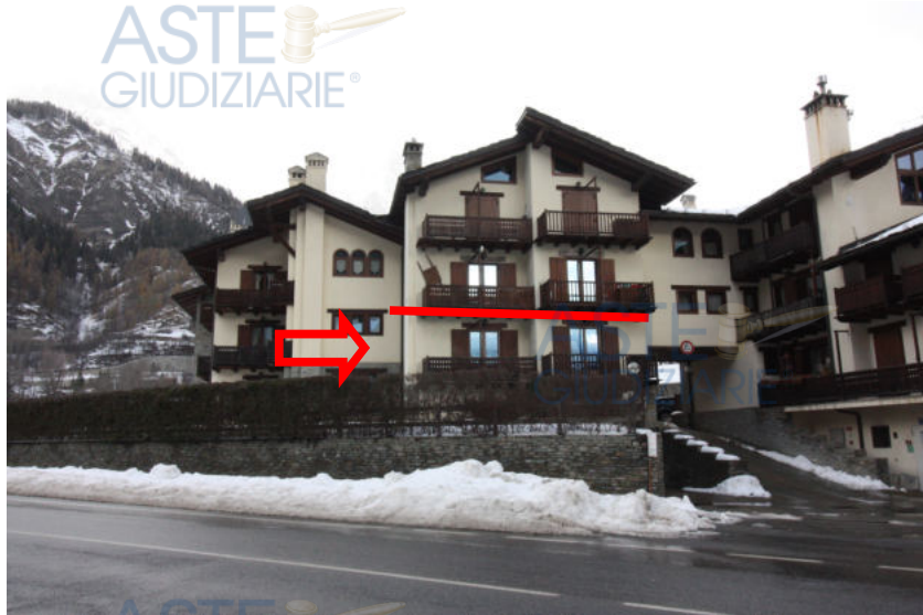
VISTA DALLA STRADA STATALE 26 – VISTA SUD
