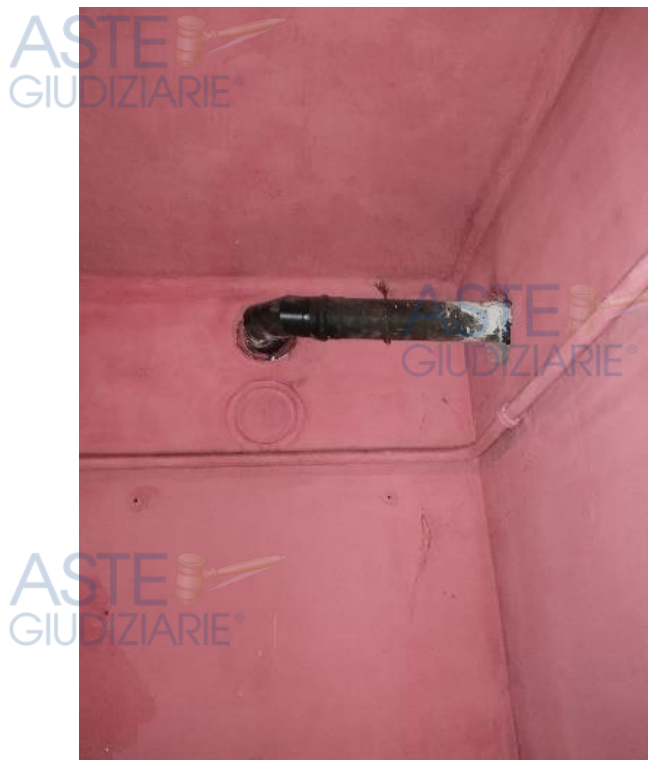
Collegamento stufa a pellet a canna fumaria
