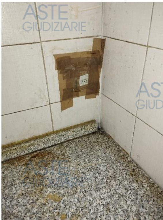
presa elettrica con scotch
