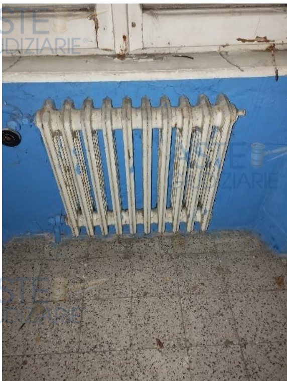
Corpo scaldante in ghisa
