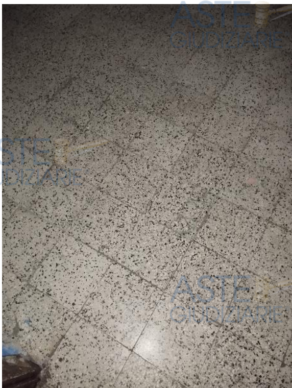
Pavimento camera da letto
