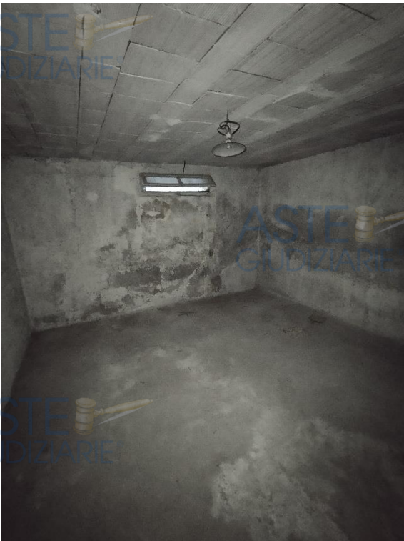
Vista da entrata verso nord
