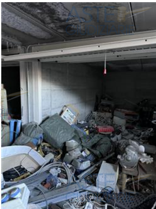
Interno di un Box
