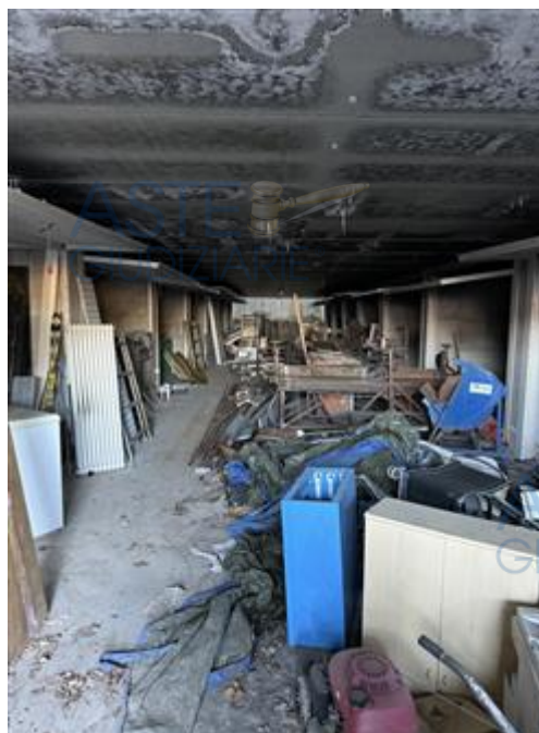
Corsia Comune Autorimessa Piano S2
