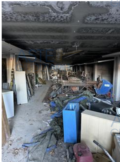
Corsia Comune Autorimessa Piano S2
