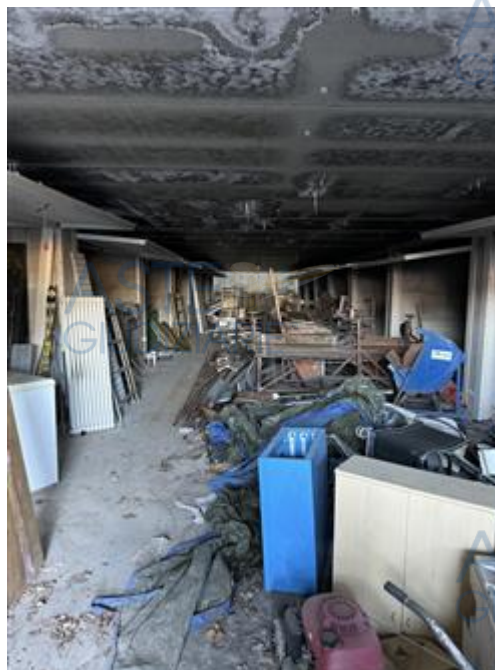
Corsia Comune Autorimessa Piano S2
