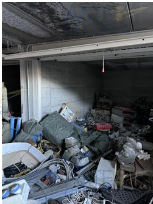
Interno di un Box
