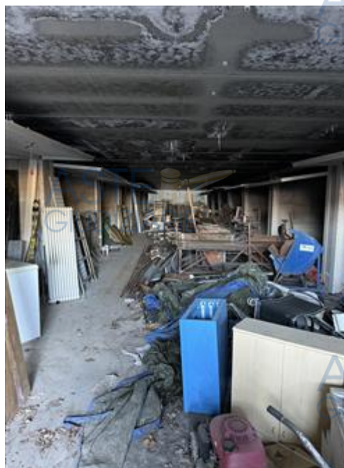
Corsia Comune Autorimesse Piano S2
