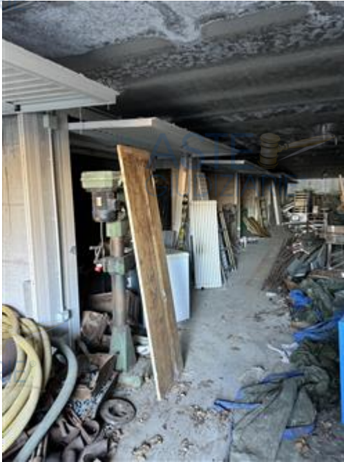
Corsia Comune Autorimessa Piano S2
