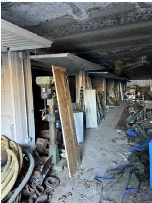
Corsia Comune Autorimesse Piano S2
