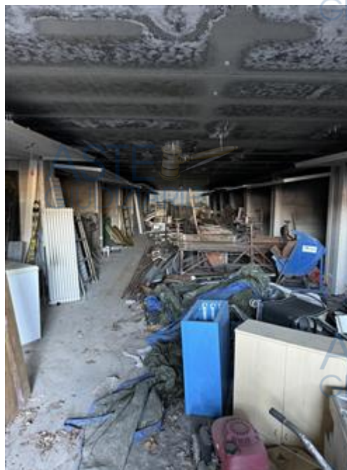
Corsia Comune Autorimessa Piano S2
