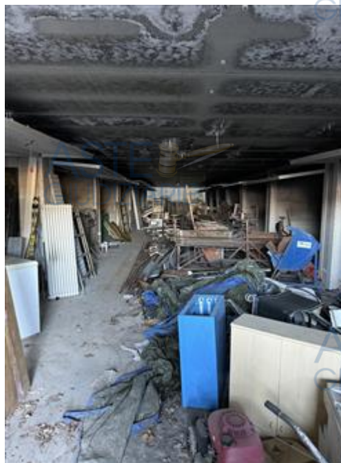
Corsia Comune Autorimessa Piano S2
