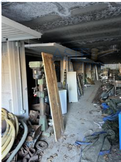
Corsia Comune Autorimessa Piano S2
