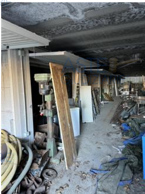
Corsia Comune Autorimessa Piano S2
