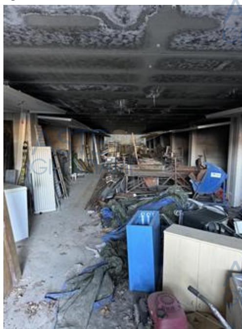
Corsia Comune Autorimesse Piano S2
