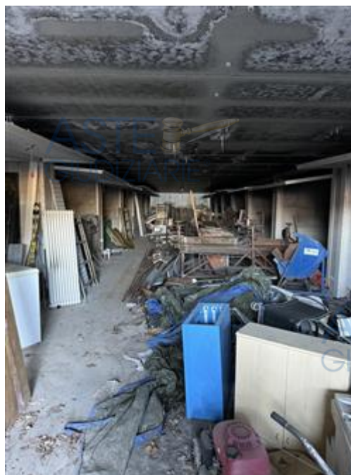
Corsia Comune Autorimessa Piano S2
