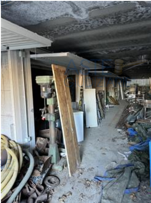
Corsia Comune Autorimessa Piano S2
