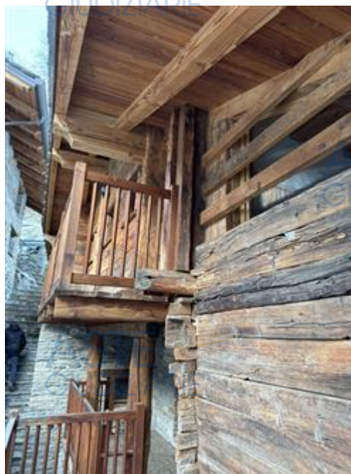
Veduta esterna Fabbricato
