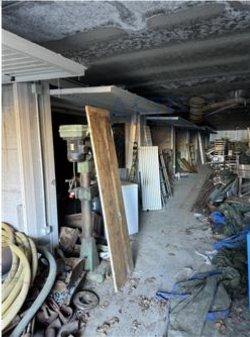
Corsia Comune Autorimessa Piano S2
