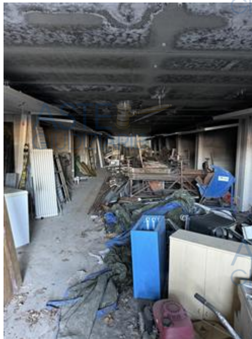
Corsia Comune Autorimessa Piano S2
