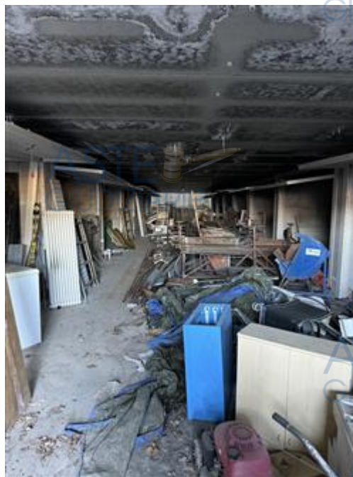
Corsia Comune Autorimesse Piano S2
