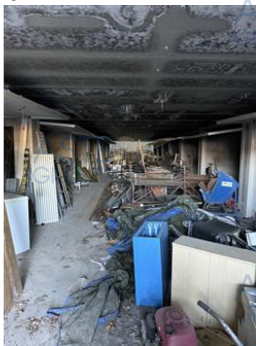
Corsia Comune Autorimesse Piano S2
