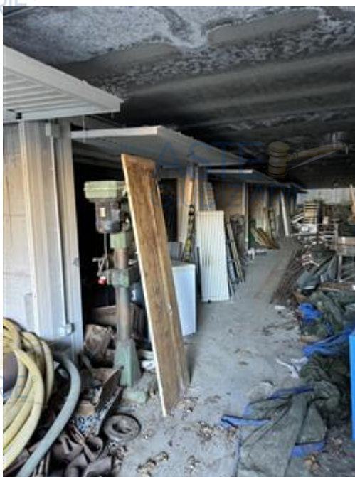
Corsia Comune Autorimessa Piano S2
