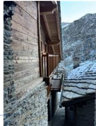
Veduta esterna Fabbricato
