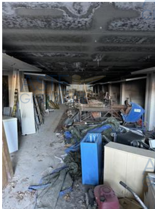
Corsia Comune Autorimesse Piano S2
