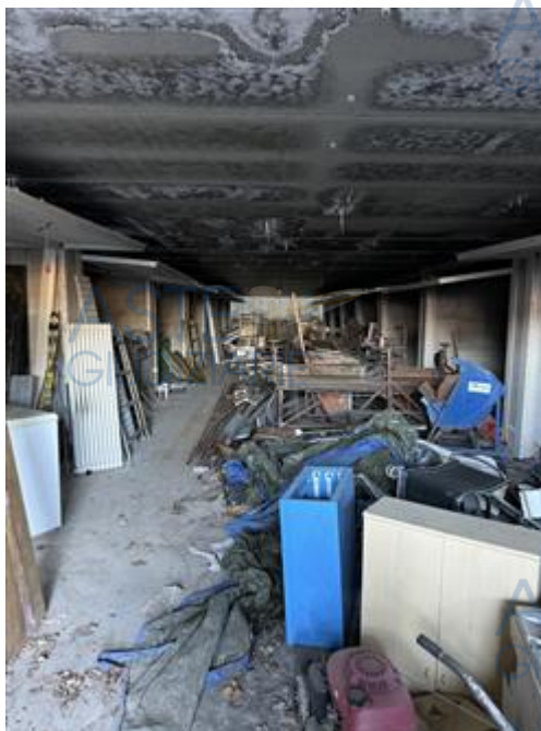
Corsia Comune Autorimessa Piano S2
