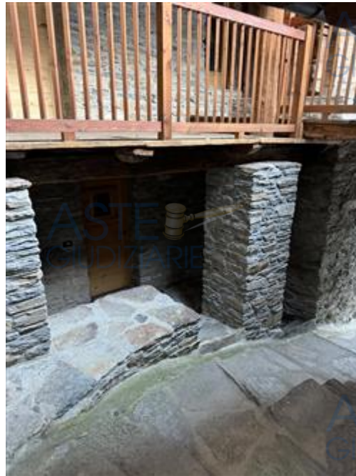
Veduta esterna con ingresso Appartamento Piano Terra
