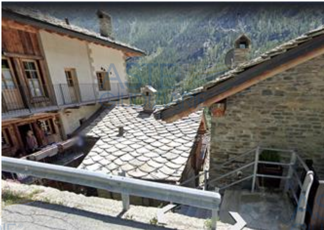
Veduta esterna Fabbricato
