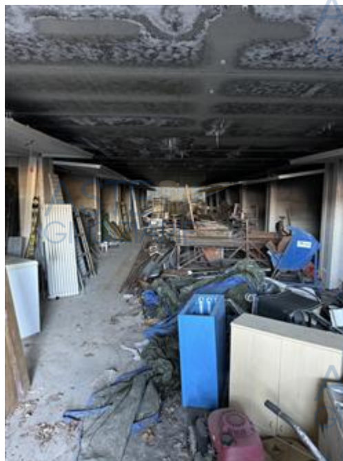
Corsia Comune Autorimessa Piano S2
