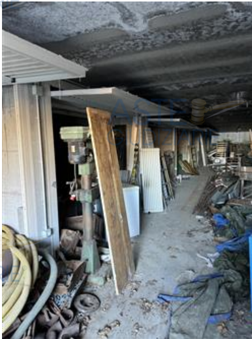
Corsia Comune Autorimessa Piano S2
