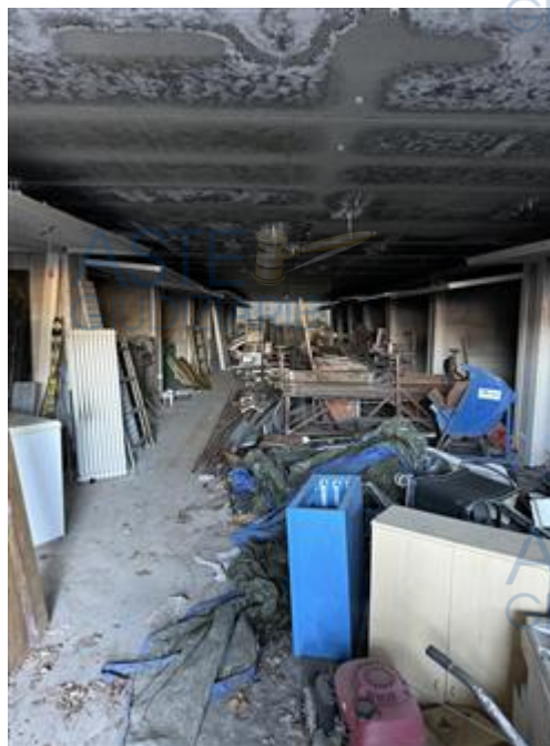
Corsia Comune Autorimessa Piano S2
