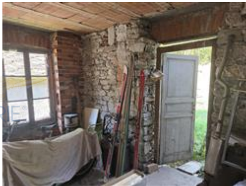
Deposito piano terra
