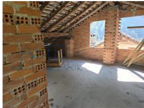
Deposito piano primo
