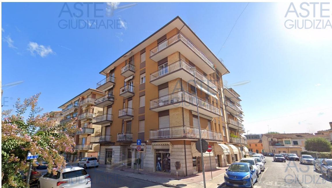
Fig. 2 Vista esterna dell'Edificio – Via D. Alighieri, 10 – Chiaravalle (AN)
