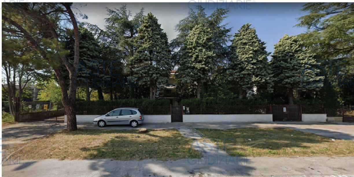
Fig. 2 Vista dalla strada esterna alla corte comune – Viale Gallodoro 79 – Jesi (AN)
