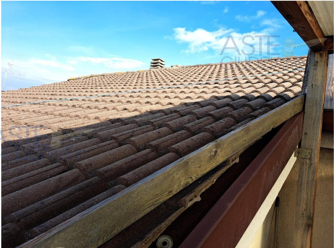
Fig. 14 Vista del tetto di copertura – risulta in buone condizioni
