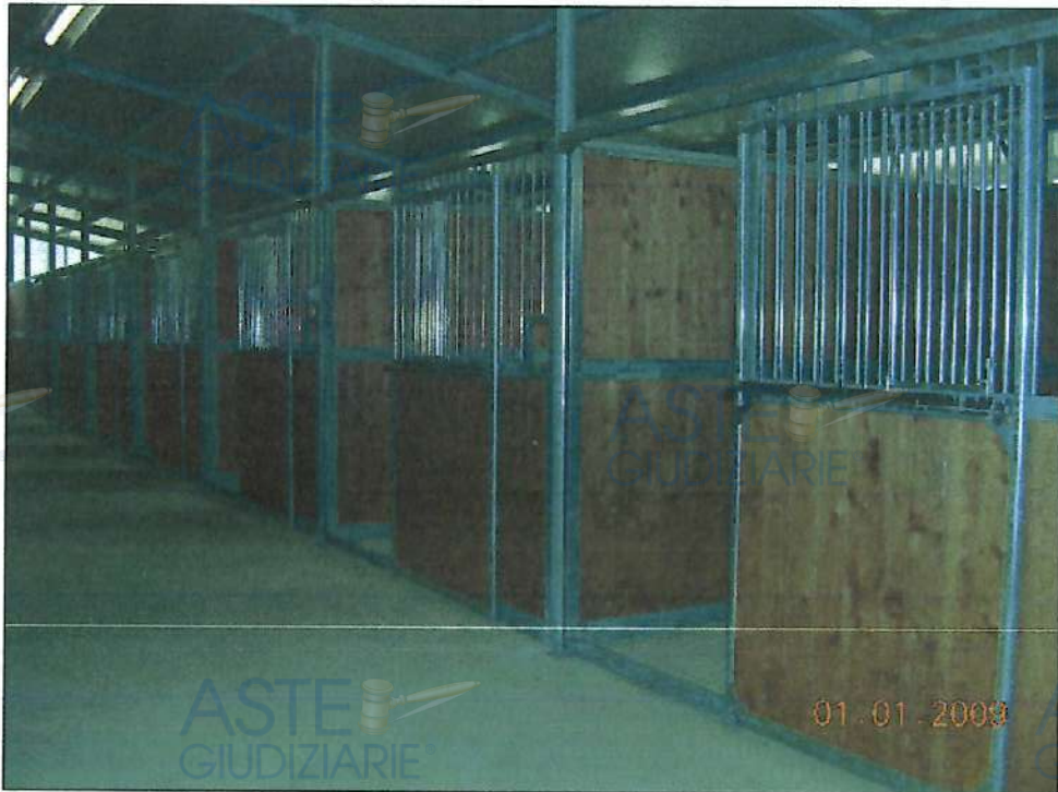
FOTO 11 - Mappale 486 - Particolare interno
