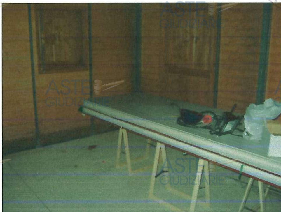
FOTO 4 - Mappale 483 - Particolare interno
