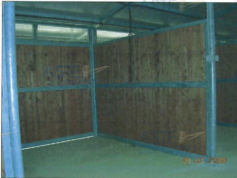
FOTO 12 - Mappale 486 - Particolare interno
