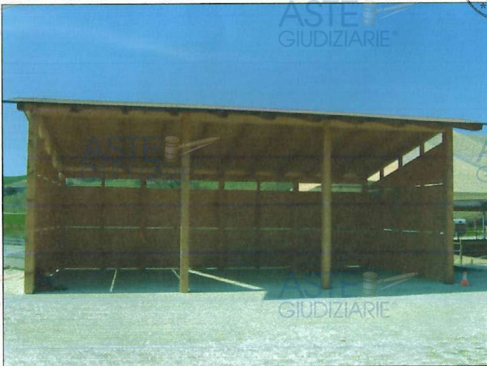
FOTO 6 - Mappale 484 - Particolare interno
