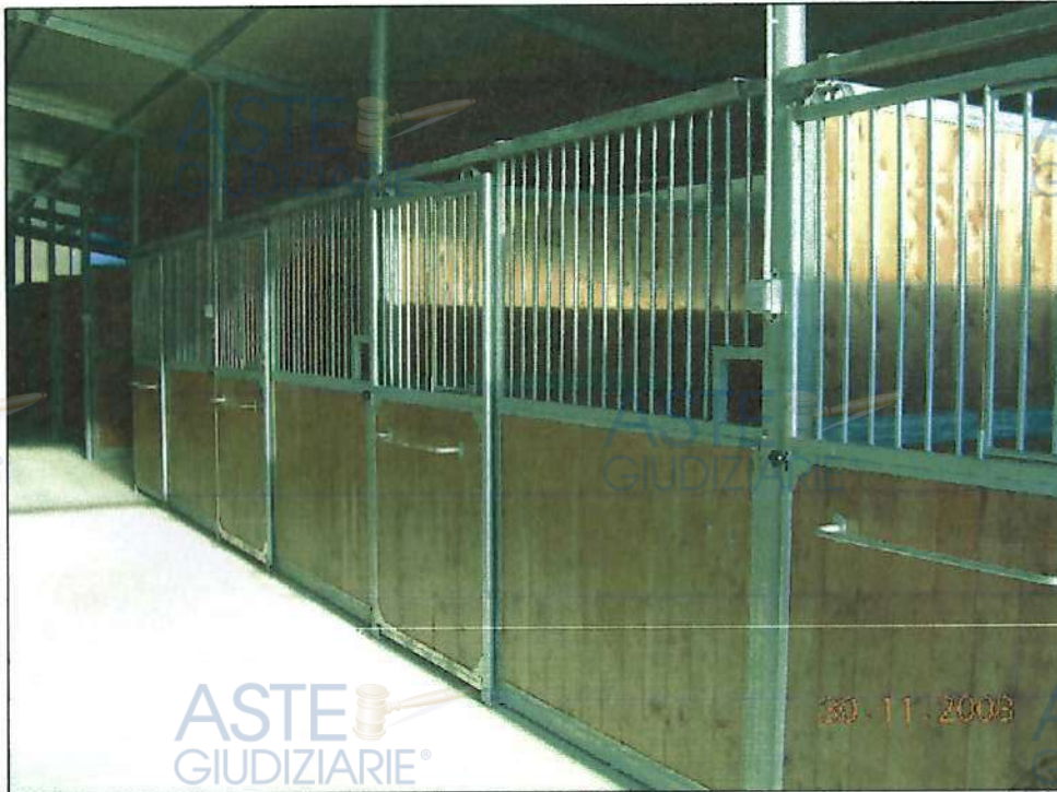
FOTO 9 - Mappale 485 - Particolare interno
