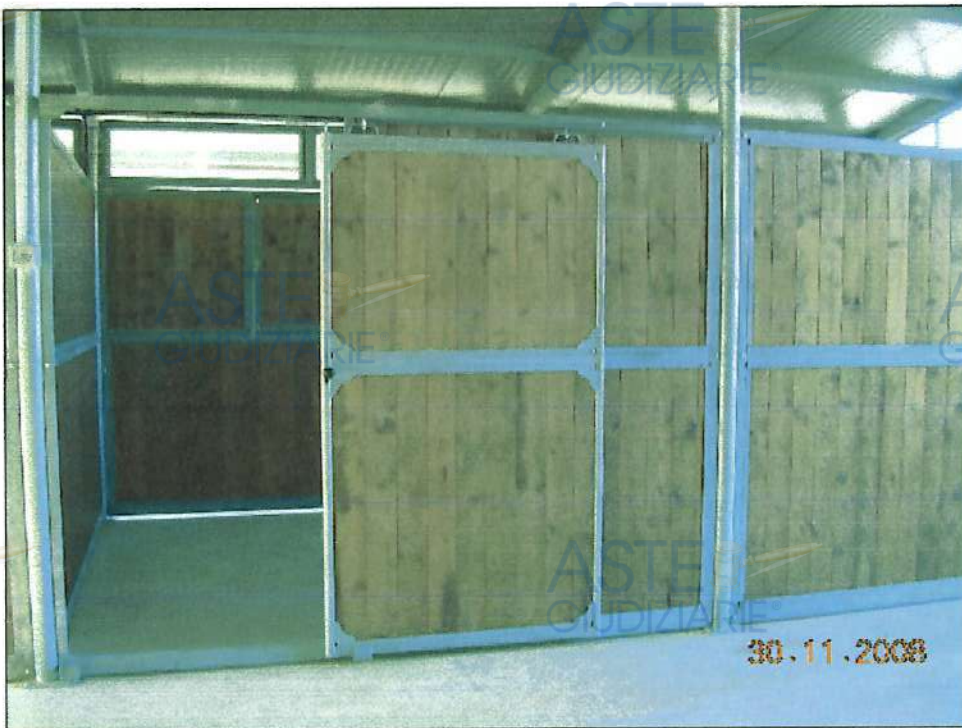
FOTO 10 - Mappale 485 - Particolare interno
