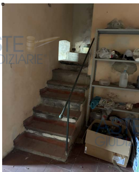
Scala dalla cantina al piano terra/primo
