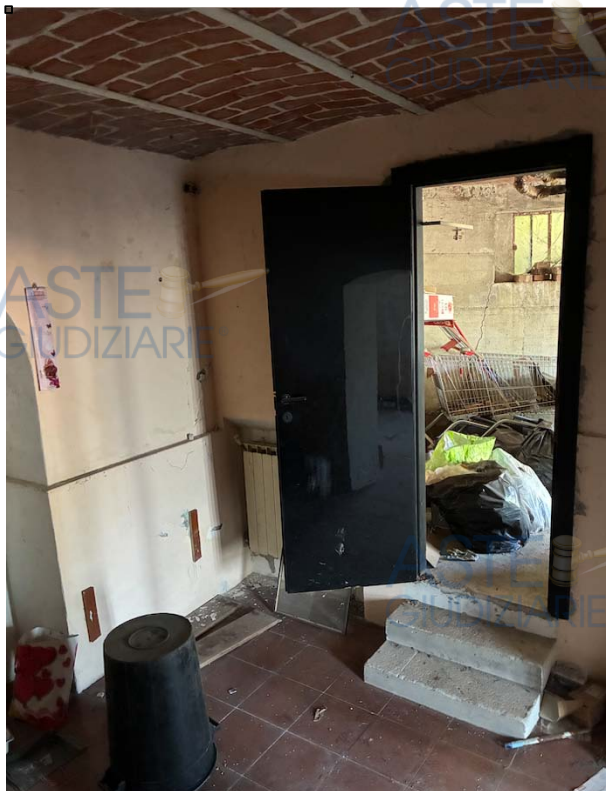
Cantina piano terra/seminterrato vista collegamento rimessa (CORPO B)
