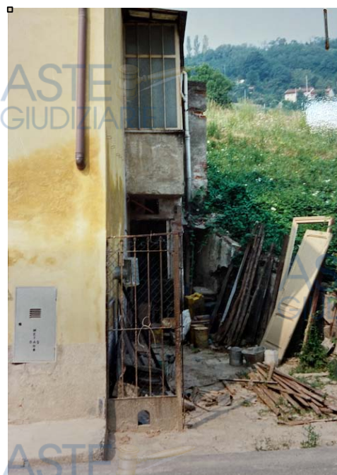
4) Foto anno 1991 allegata alla domanda di concessione all'esecuzione autorimessa
