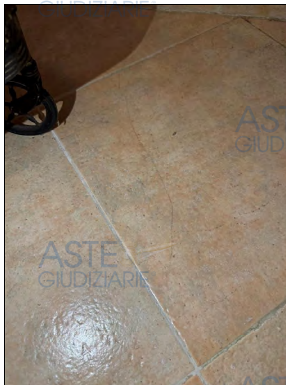
Immagini 2 – 3: vista fessurazioni su pavimentazione piano rialzato
