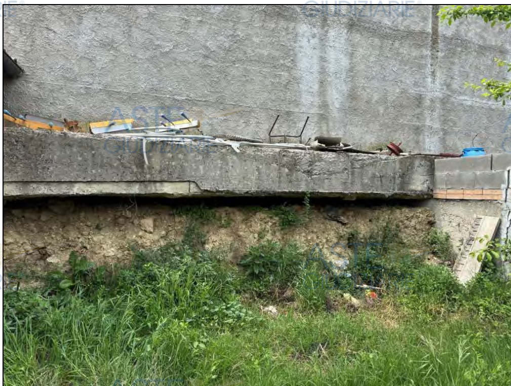
Immagine 8: muro di contenimento contro terra a monte della proprietà
