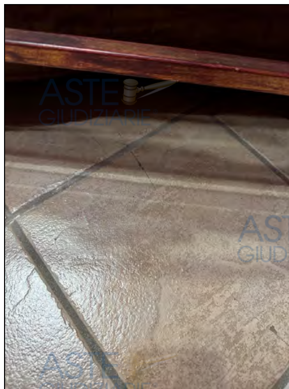
Immagini 4 – 5: vista fessurazioni su pavimentazione piano rialzato
