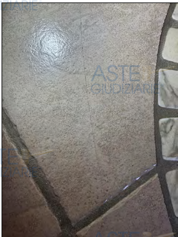
Immagini 2 – 3: vista fessurazioni su pavimentazione piano rialzato
