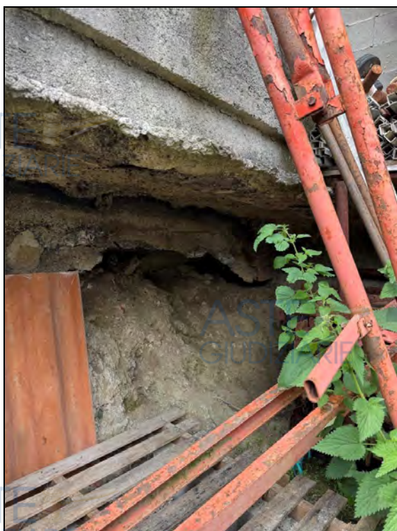
Immagini 13-14: dettaglio del muro di sostegno con mancanza di terra sotto al piede
