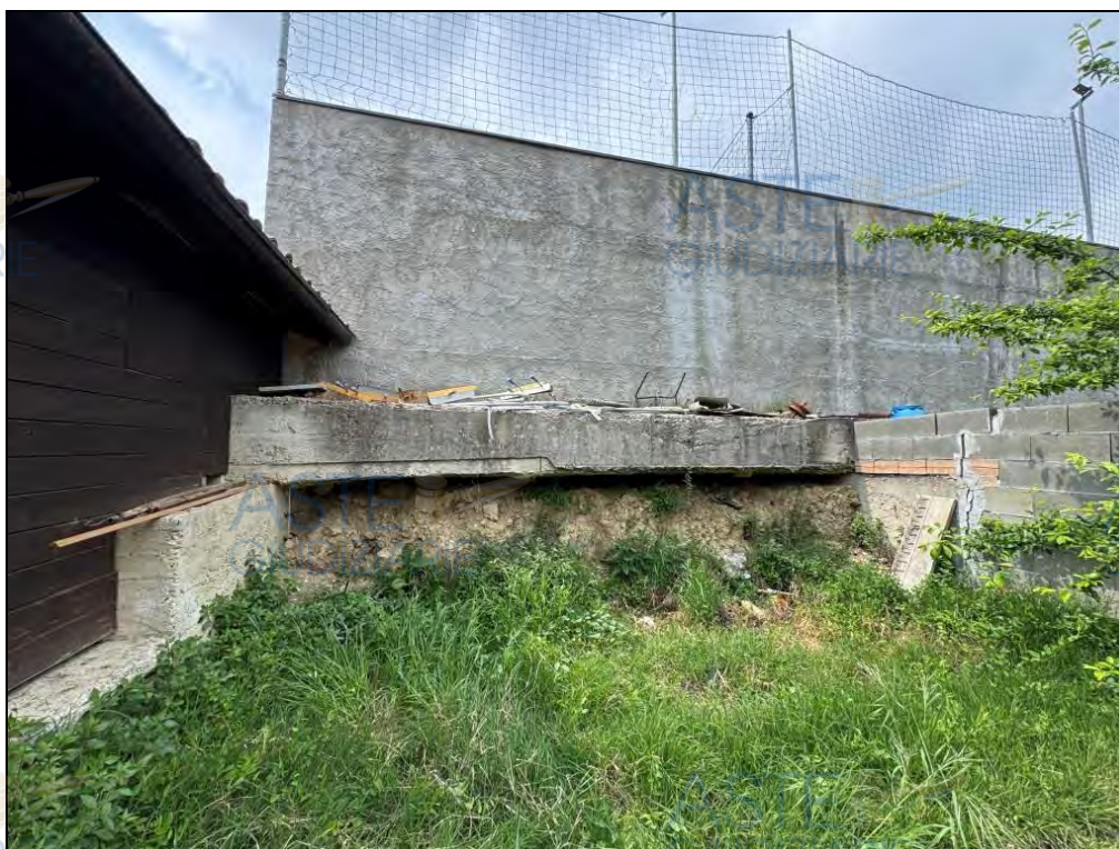
Immagine 7: muro di contenimento contro terra a monte della proprietà
