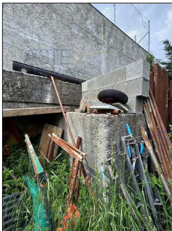
Immagini 13-14: dettaglio del muro di sostegno con mancanza di terra sotto al piede
