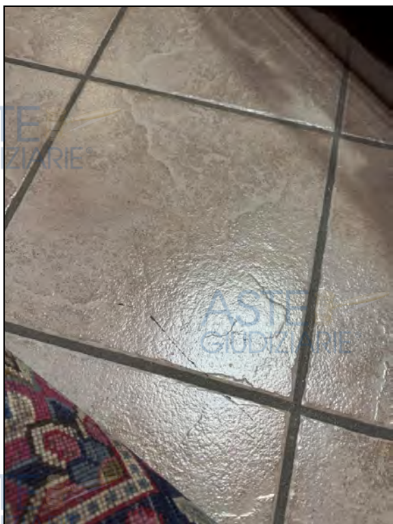
Immagini 4 – 5: vista fessurazioni su pavimentazione piano rialzato
