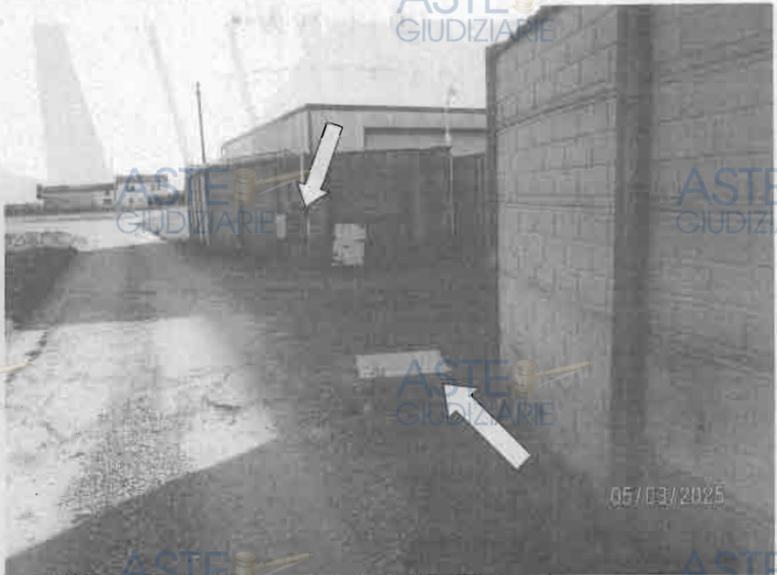
FOTO 5 – La strada vicinale su cui si affaccia il fronte Est del complesso. In primo piano il pozzetto interrato per il contatore dell'acqua. Incassato nella recinzione, il contatore gas.
