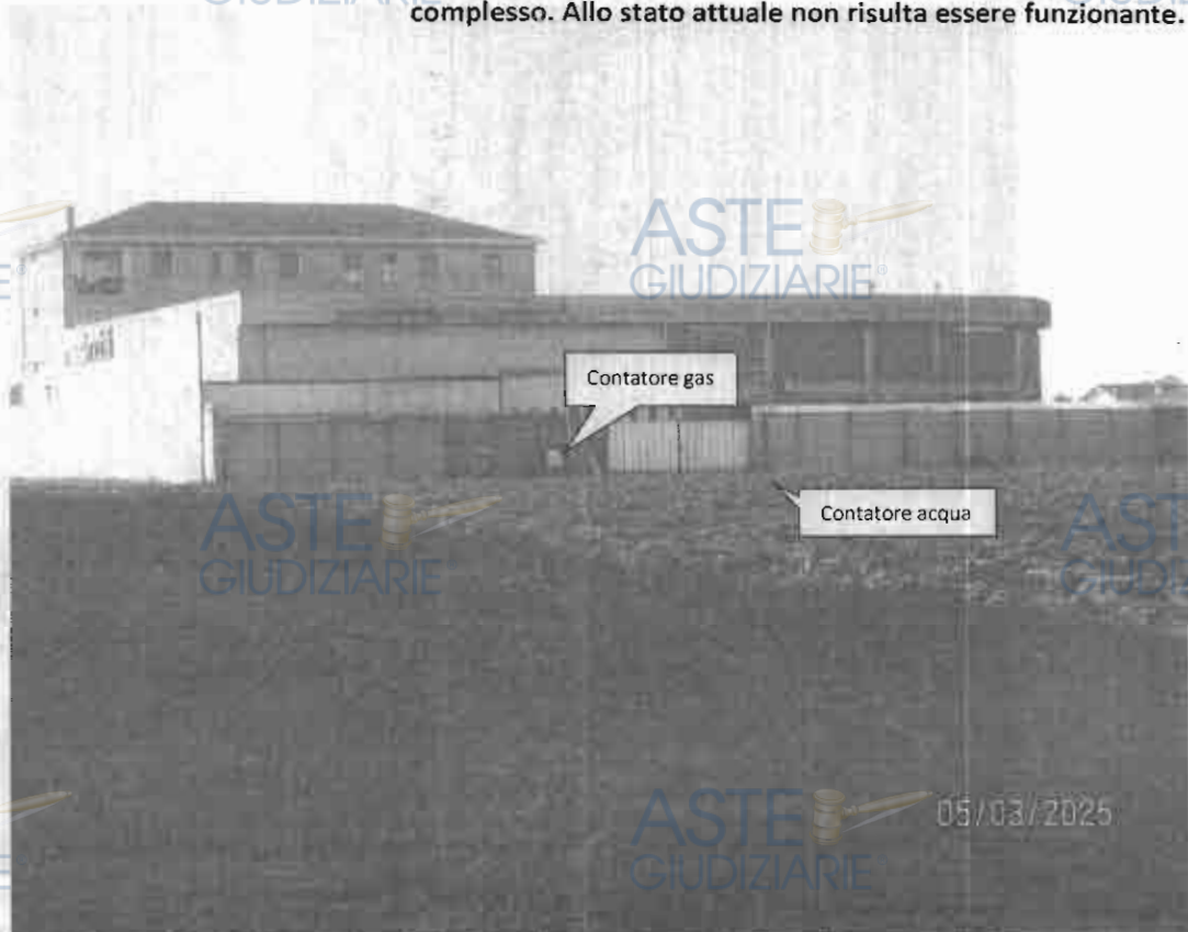
FOTO 4 – Il complesso visto dal retro, fronte Est, con indicata la posizione dei contatori, al limite della proprieta', lungo una strada vicinale.
