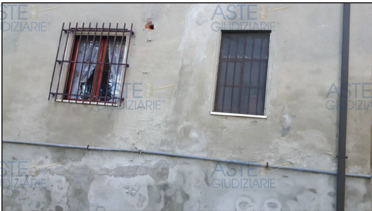
Figura 3: particolare facciata Nord / Est
