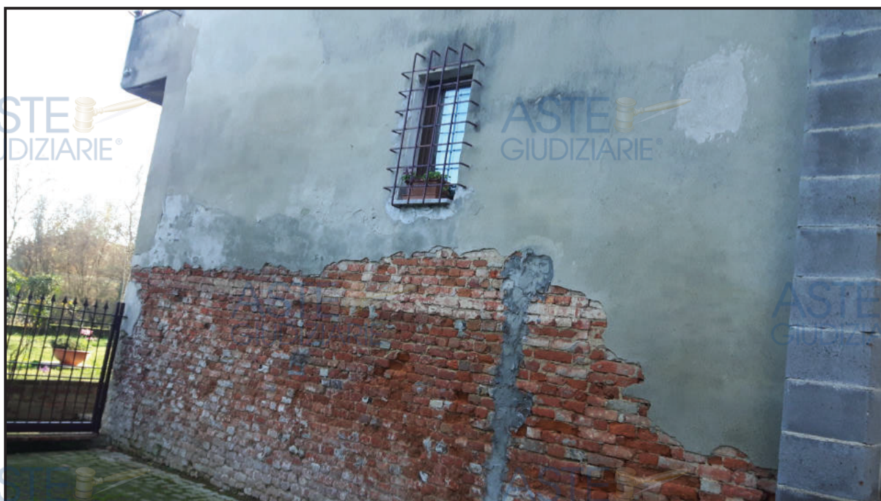
Figura 4: particolare facciata Nord / Est
