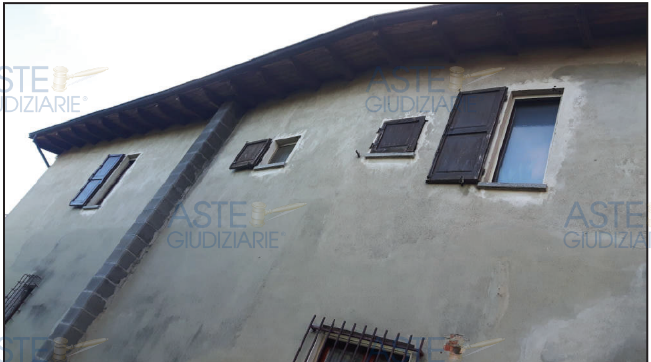
Figura 2: vista Nord / Est
