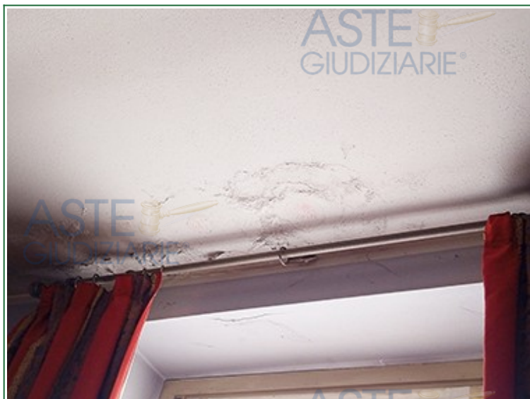
Soffitto della camera a piano primo
