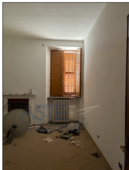
Camera angolo S-O [finestra verso strada]
