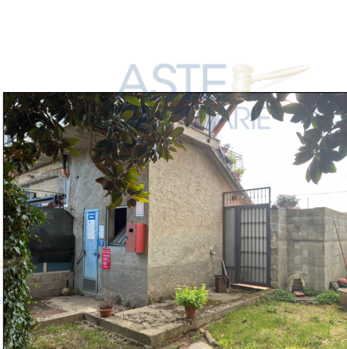
Vista da corte interna verso CT comune
