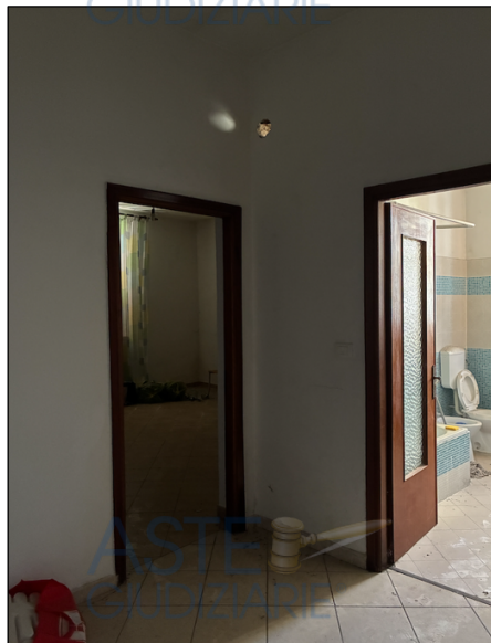
Vano di ingresso verso bagno
