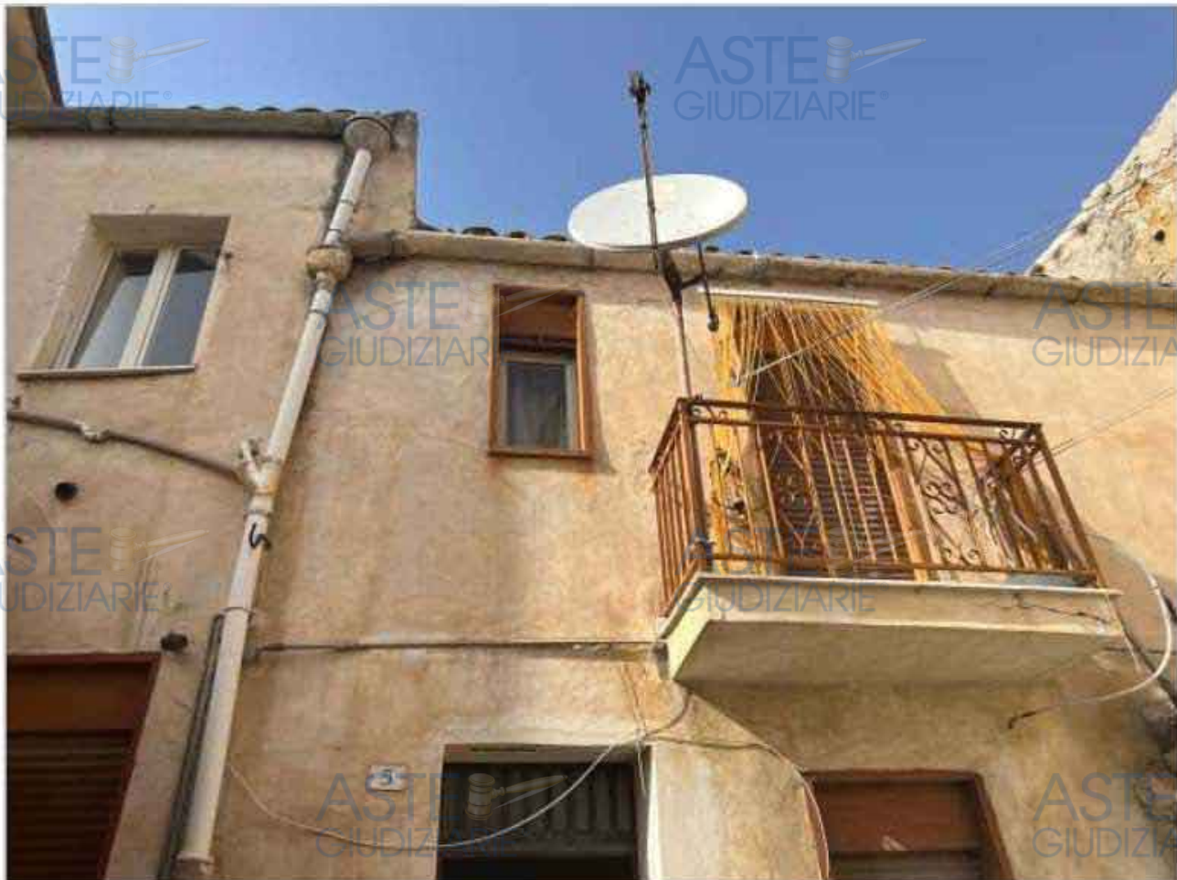
VISTA INTERNA - FRONTE SUD PIANO SECONDO
