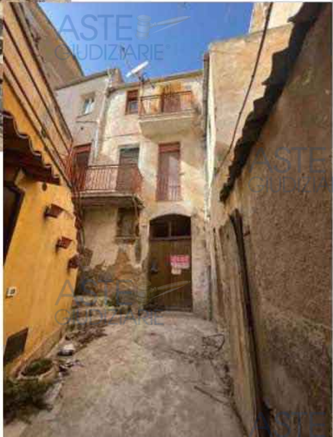
VISTA DAL CORTILE CARUANA FRONTE SUD
