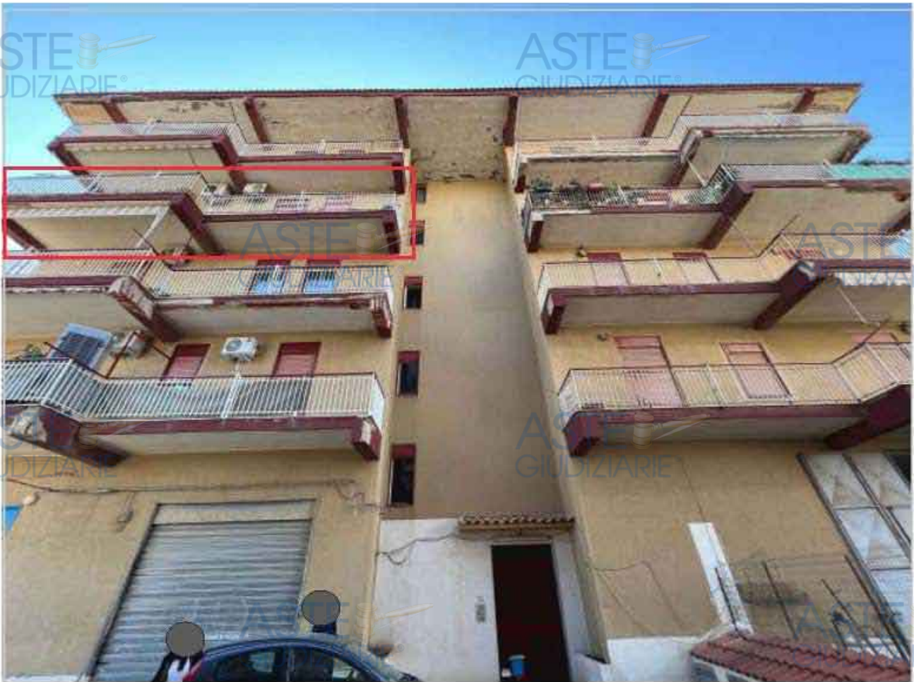
VISTA ESTERNA - FRONTE EST E VANO SCALA
