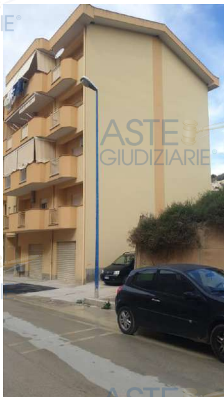
FOTO 4 - VEDUTA DEL PROSPETTO LATERALE
