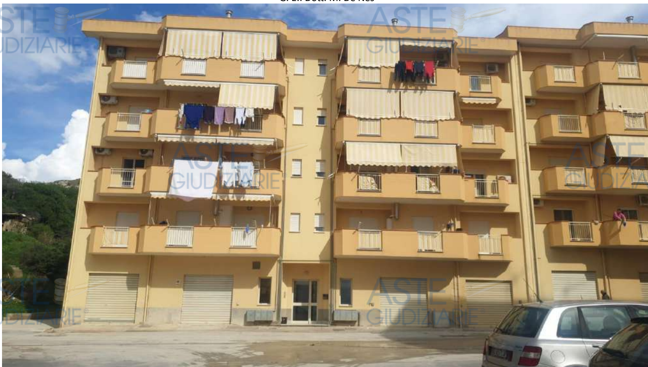
FOTO 1 - VEDUTA DEL PROSPETTO PRINCIPALE
