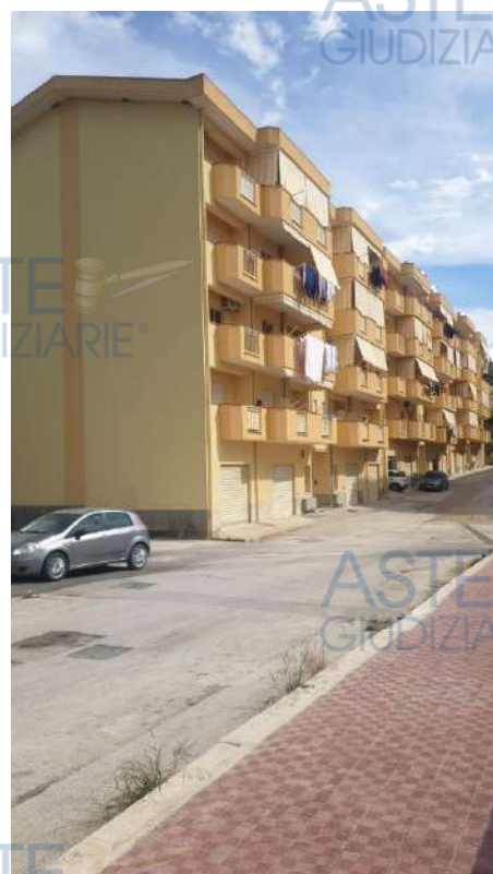
FOTO 3 - VEDUTA DEL PROSPETTO LATERALE
