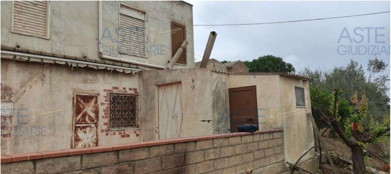
La copertura del locale forno realizzata con onduline è stata danneggiata dalla caduta della canna fumaria del forno, entrambi gli elementi sono realizzati in Fibrocemento a base di amianto.
