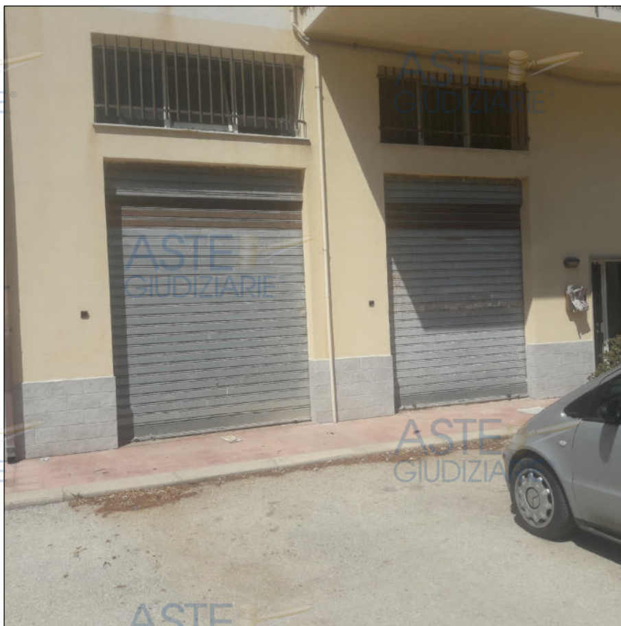
Prospetto sud (prime due saracinesche)
