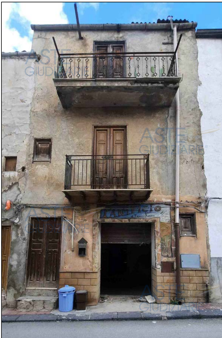
Foto accesso anteriore su via Oreto n. 131 Piano Terra – Panificio
