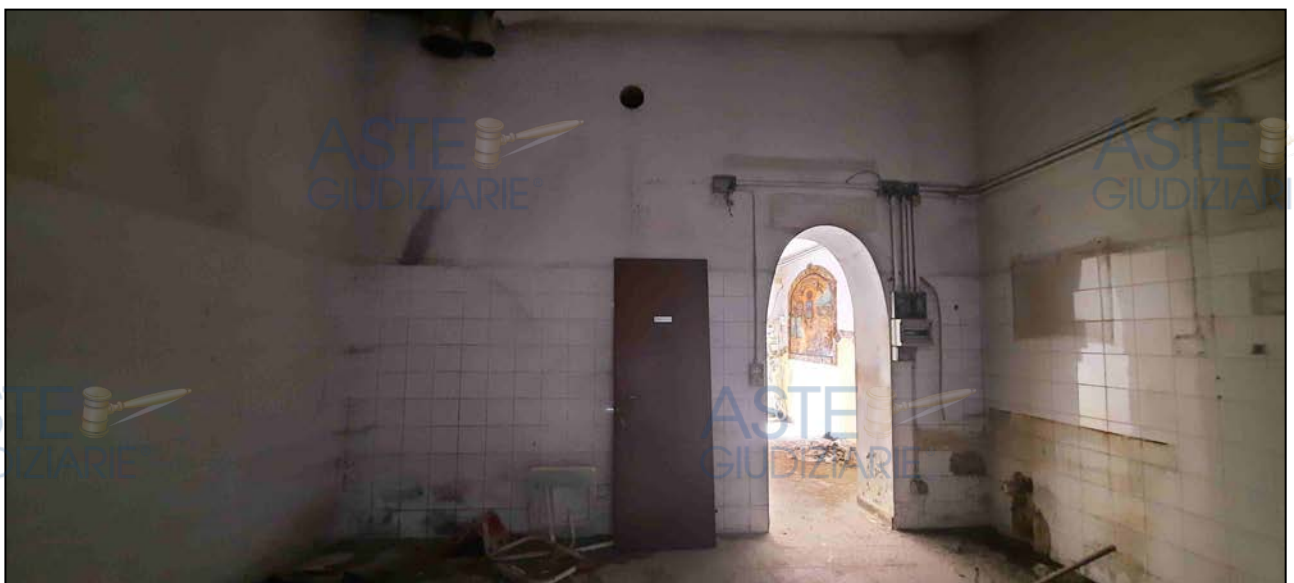
Foto interne Locale Laboratorio con accesso posteriore da via del Balilla – P.T.
