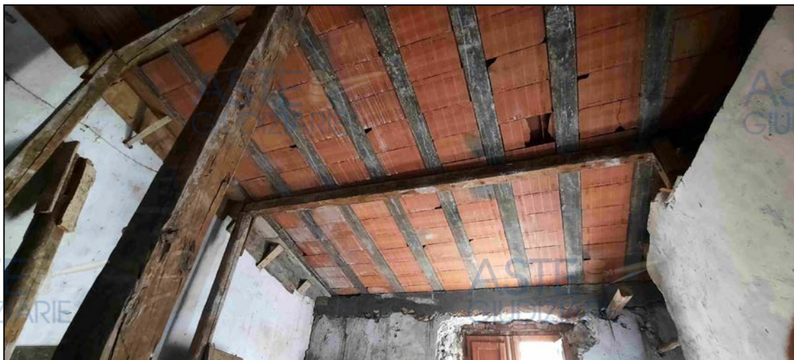
Copertura zona notte Secondo Piano
