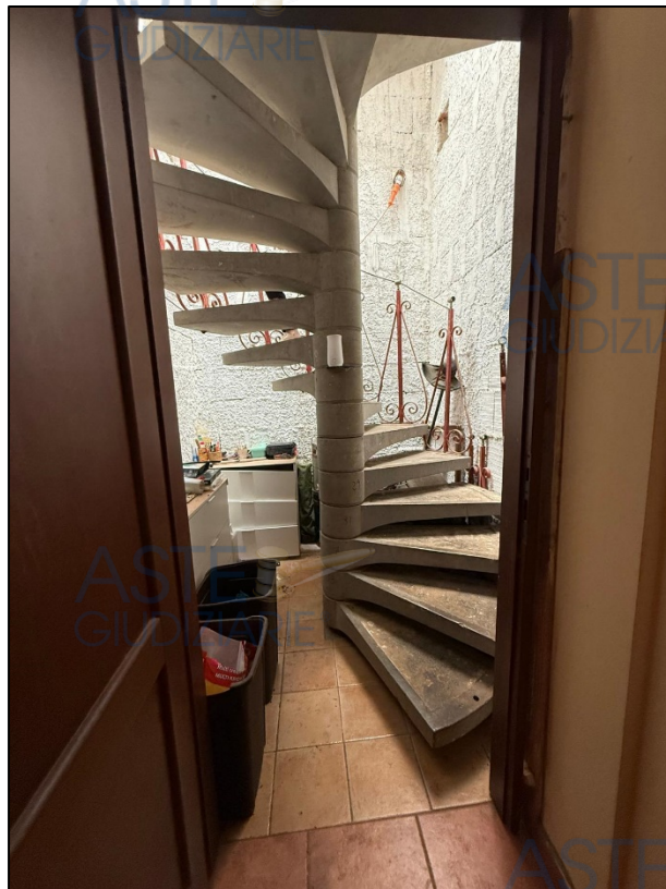
FIGURA 12: SCALA DI COLLEGAMENTO TRA I DUE LIVELLI
