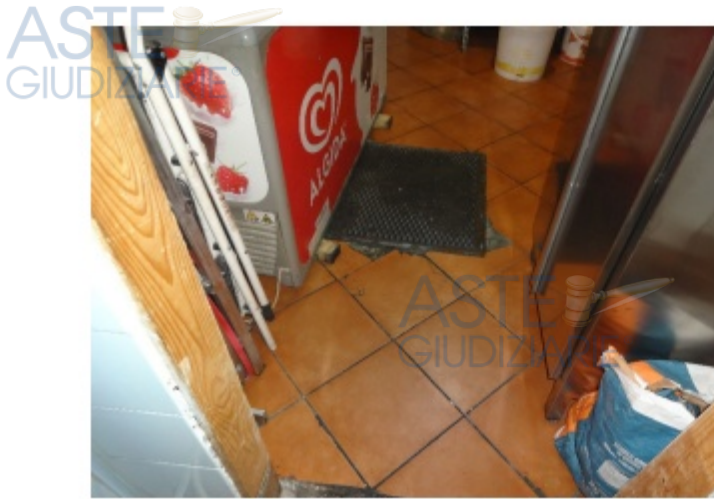
Foto 11 - Deposito n.1 (botola della vasca idrica interrata)
