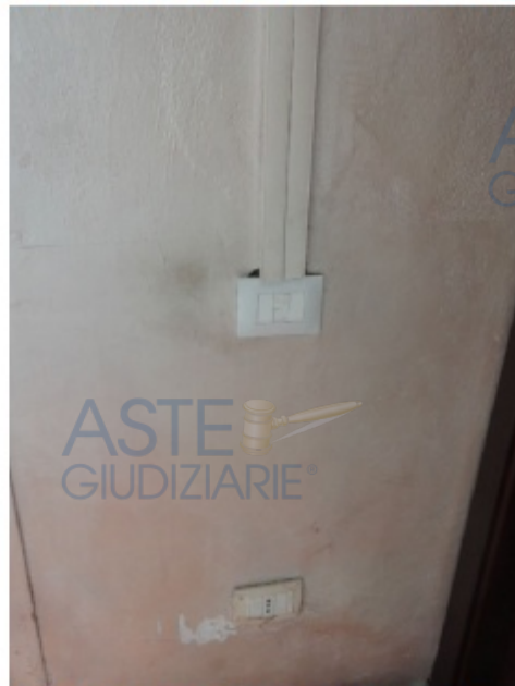
Foto 10 - Intonaci e impianto elettrico della zona vendita
