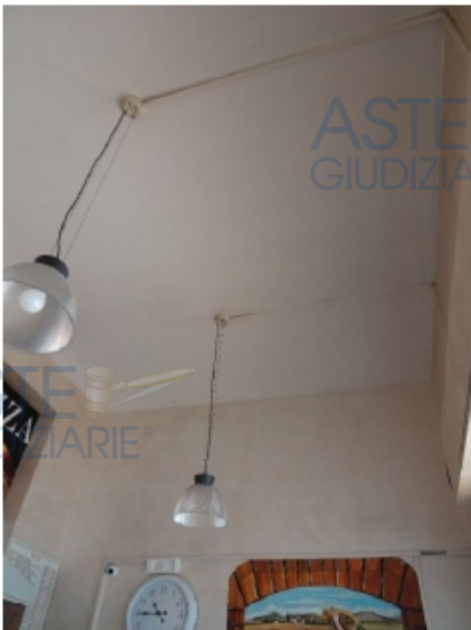
Foto 9 - Intonaci e impianto elettrico della zona vendita
