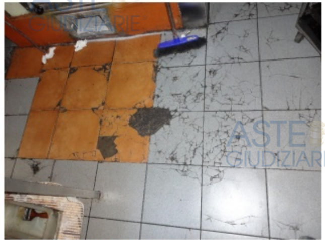
Foto 30 - Pavimento del laboratorio
