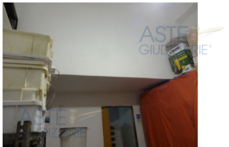
Foto 16 - Deposito n.1 (nella foto si noti il controsoffitto)
