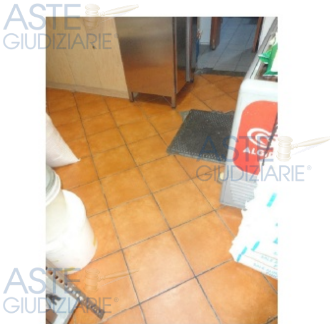
Foto 13 - Deposito n.1 (botola della vasca idrica interrata)
