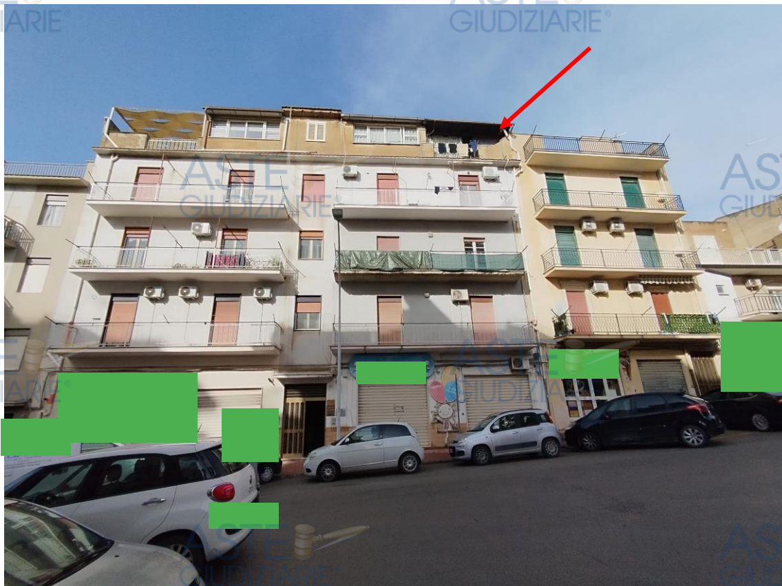
Foto 4 – Veduta dell'appartamento da via Senatore Sammartino
