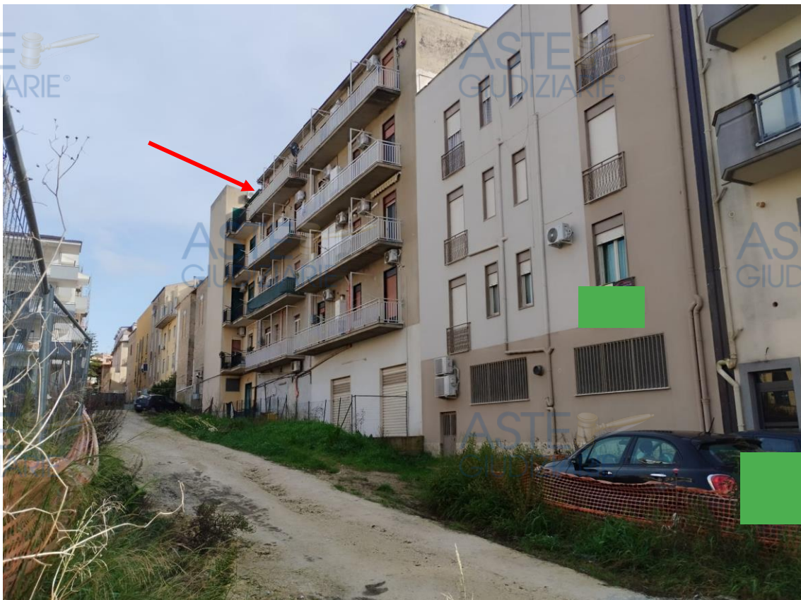
Foto 3 – Veduta dell'appartamento posto al quarto piano
