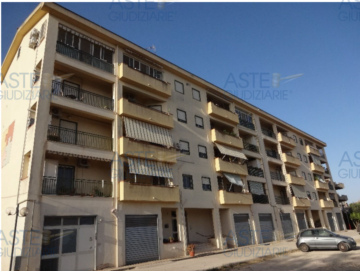
Foto 2-Prospetto principale del fabbricato in cui è ubicato il cespite costituente il lotto (via Nilde Iotti)
