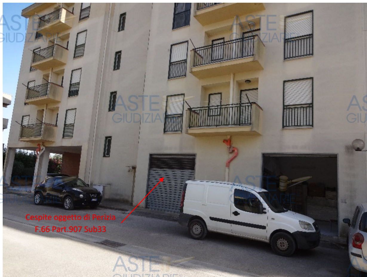
Foto 5-Cespite oggetto di perizia (prospetto posteriore del fabbricato)
