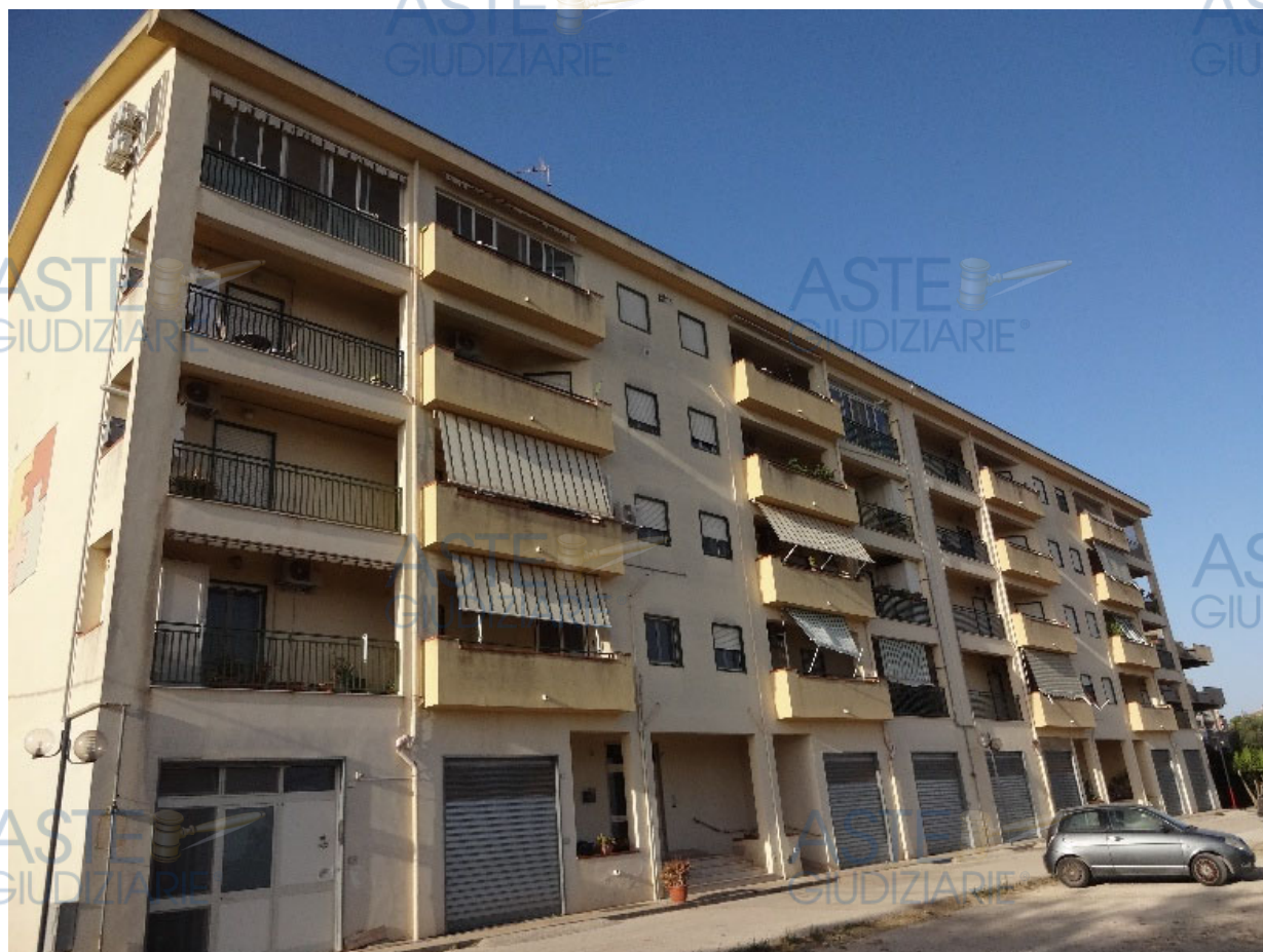
Foto 2-Prospetto principale del fabbricato in cui è ubicato il cespite costituente il lotto (via Nilde Iotti)
