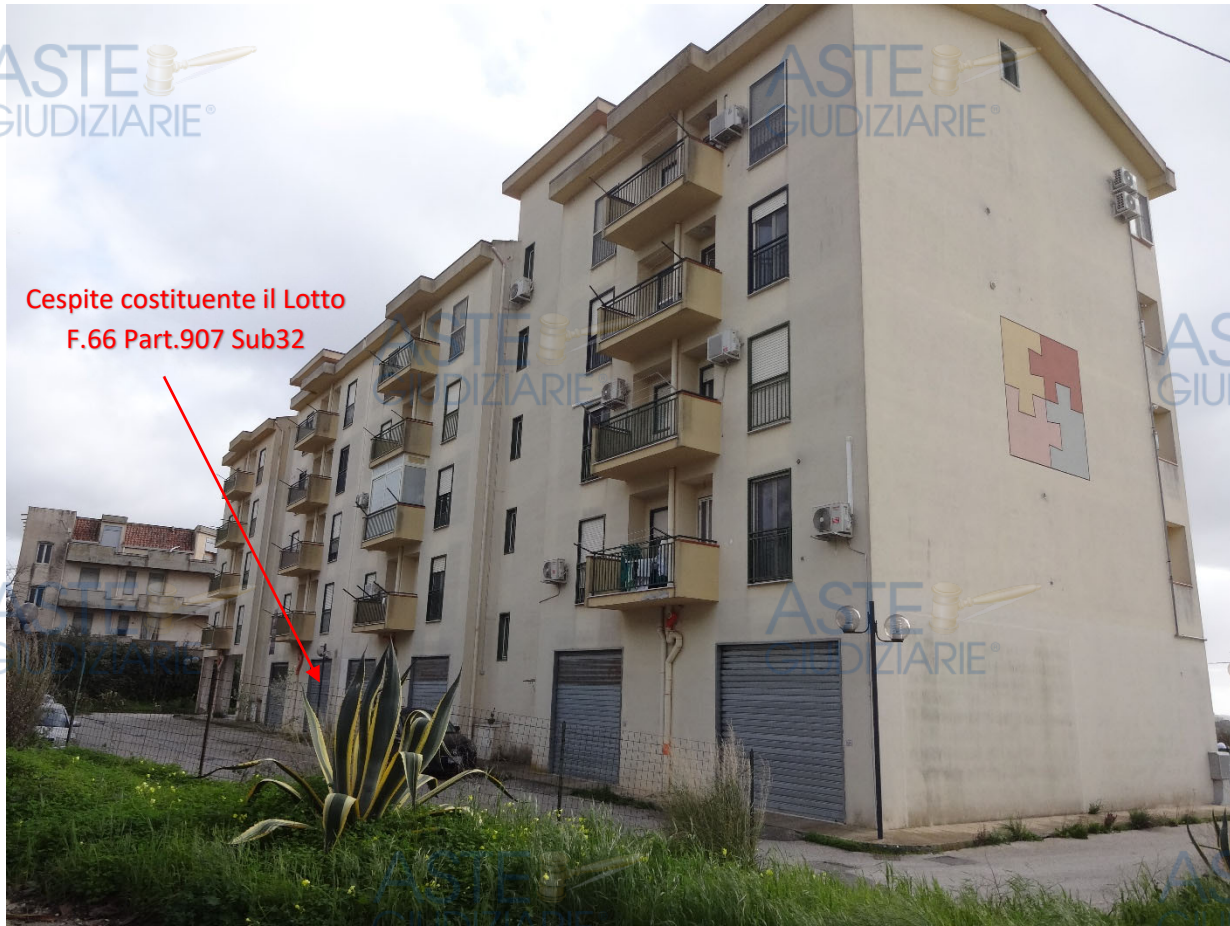
Foto 3-Prospetto posteriore del fabbricato
