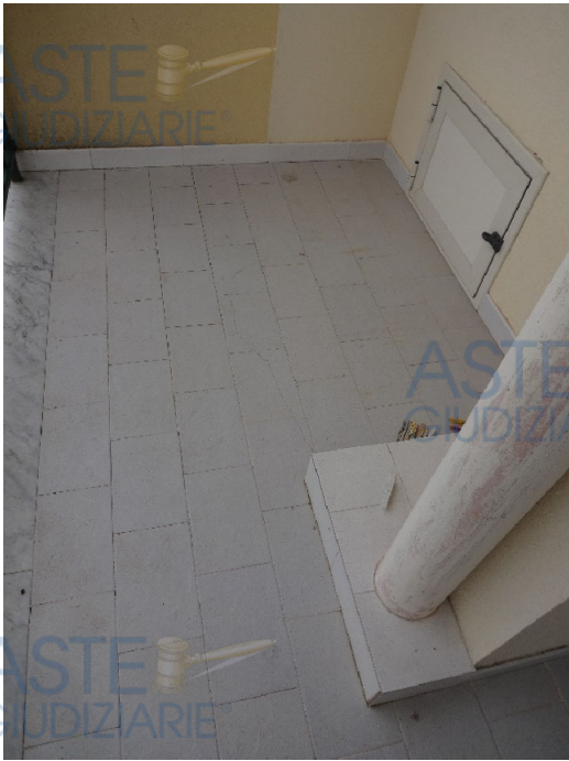
Foto 25-Balcone in corrispondenza del prospetto posteriore
