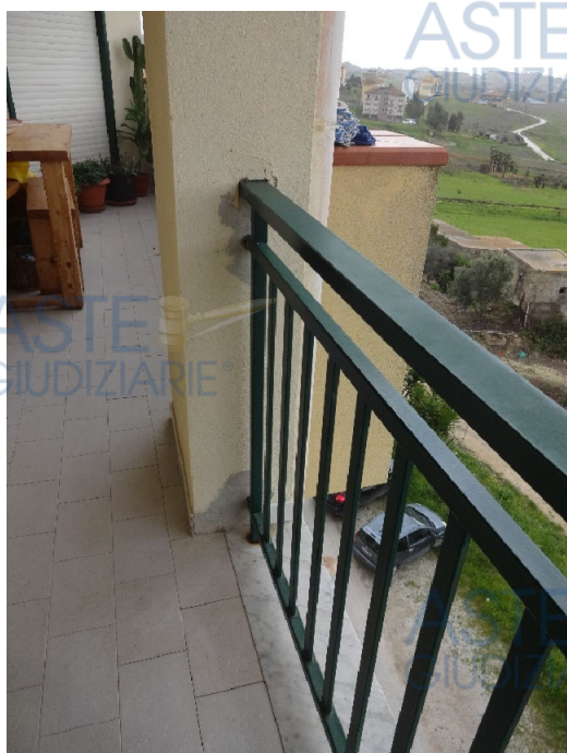
Foto 43-Veranda in corrispondenza del prospetto principale
