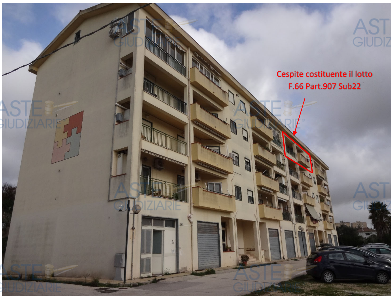
Foto 2-Prospetto principale su via Nilde Iotti
