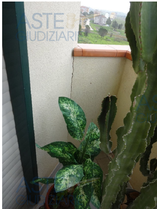
Foto 42-Veranda in corrispondenza del prospetto principale
