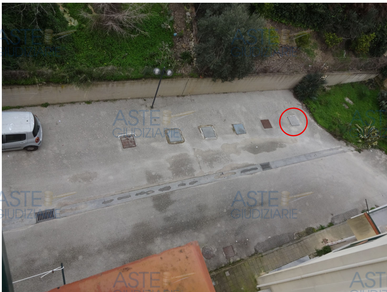
Foto 6-Vasche idriche in area di parcheggio. Pubblicazione ufficiale ad uso esclusivo personale. È vietata ogni riproduzione o riproduzione a scopo commerciale. Aut. Min. Giustizia PDG 21/07/2009
