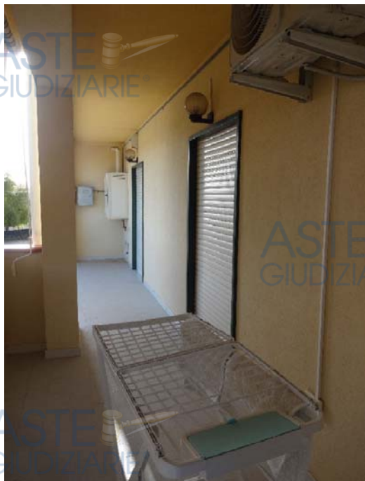
Foto 35-Veranda in corrispondenza del prospetto principale
