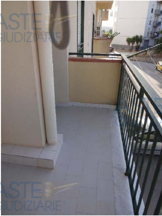
Foto 23-Balcone a servizio del WC n.1 e del WC n.2
