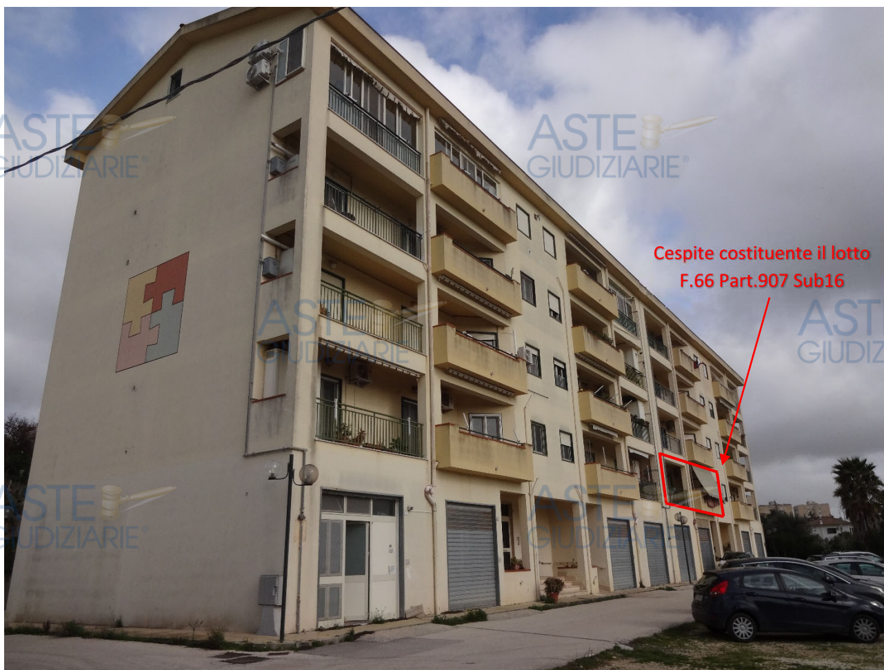
Foto 2-Prospetto principale su via Nilde Iotti (03.01.2026)
