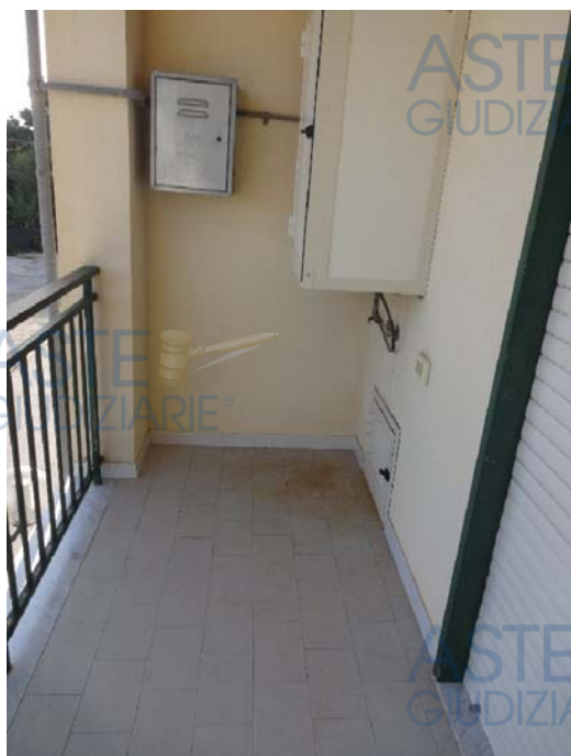
Foto 37-Veranda in corrispondenza del prospetto principale
