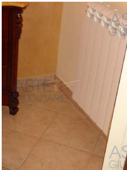
Foto 26-Interni del vano n.2
