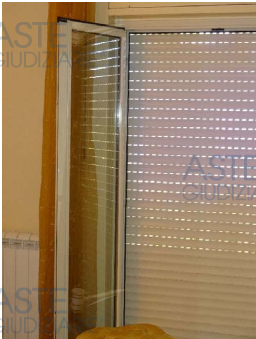
Foto 27-Interni del vano n.2
