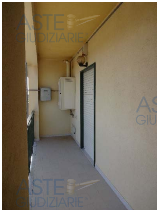
Foto 36-Veranda in corrispondenza del prospetto principale
