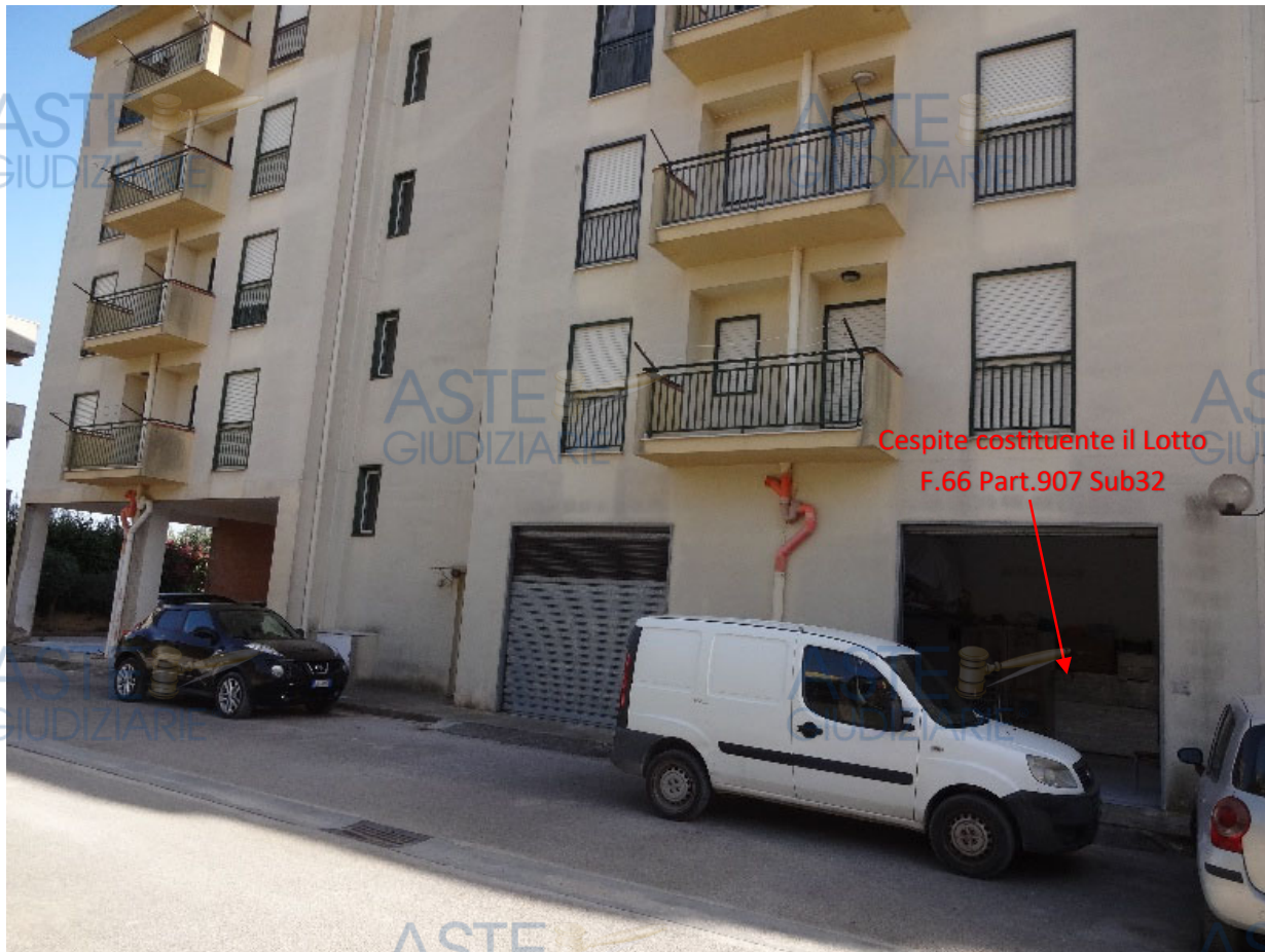
Foto 4-Prospetto posteriore del fabbricato
