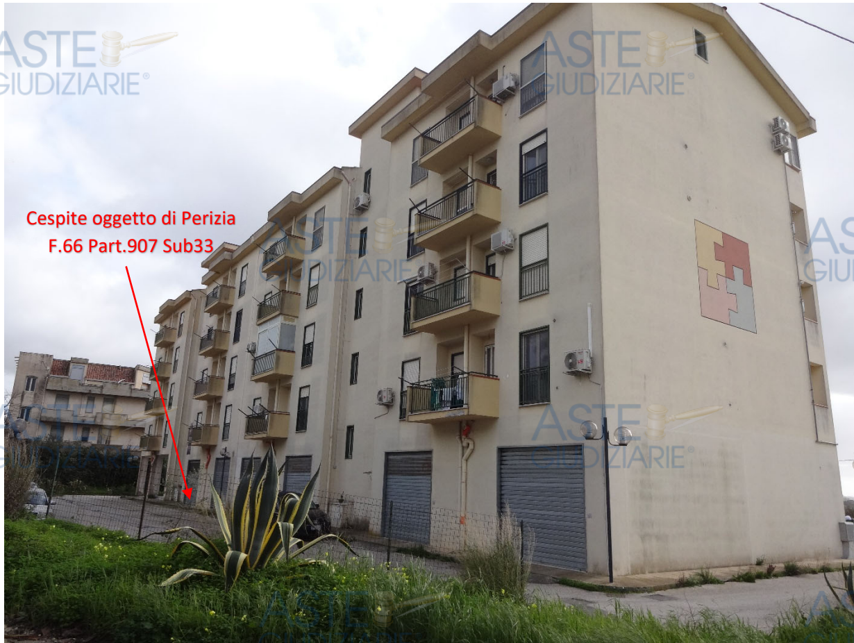
Foto 3-Cespite oggetto di perizia (prospetto posteriore del fabbricato)
