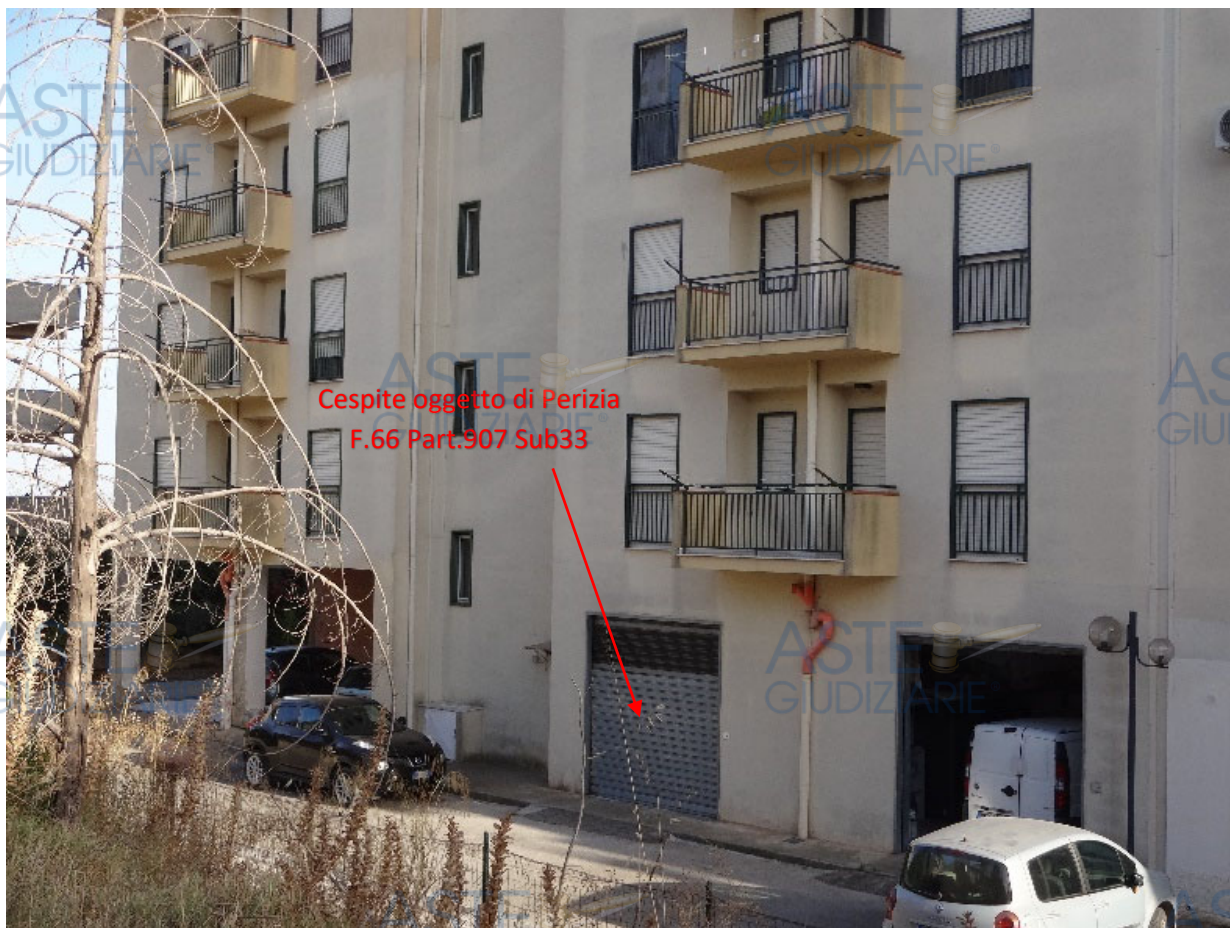
Foto 4-Cespite oggetto di perizia (prospetto posteriore del fabbricato)
