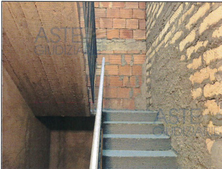
Vista del corpo scala
