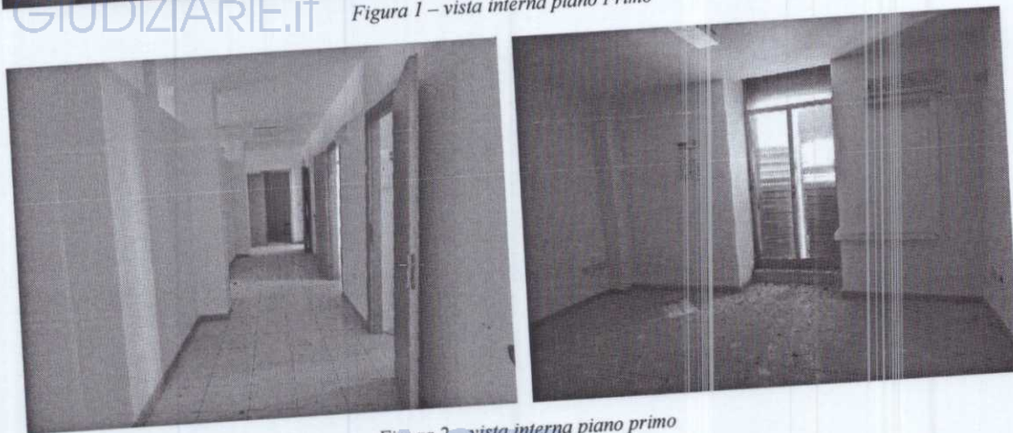
Figura 1 - vista interna piano Primo
