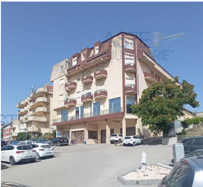
Vista del prospetto via Pablo Picasso
