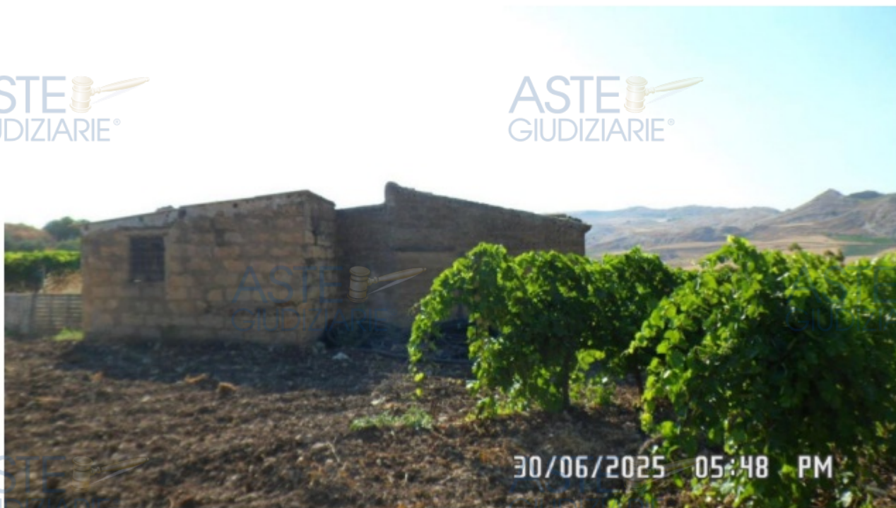
FOTO 8 - VEDUTA DA EST DEL FABBRICATO
