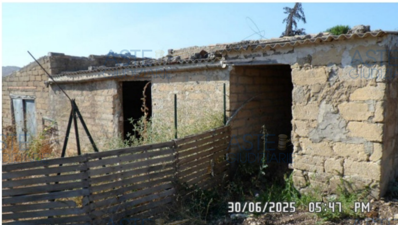
FOTO 7 - VEDUTA DA SUD DEL FABBRICATO
