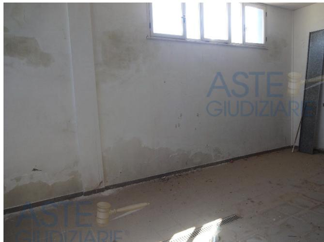
Foto 38-Particolare degli Interni (si noti la presenza di umidità)
