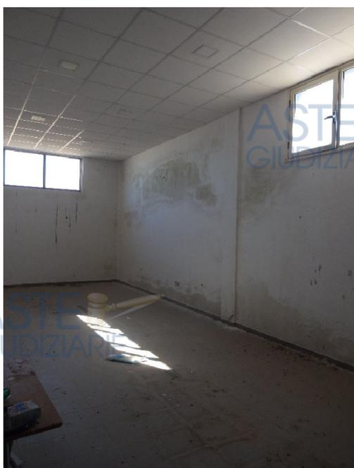
Foto 39-Particolare degli Interni (si noti la presenza di umidità)
