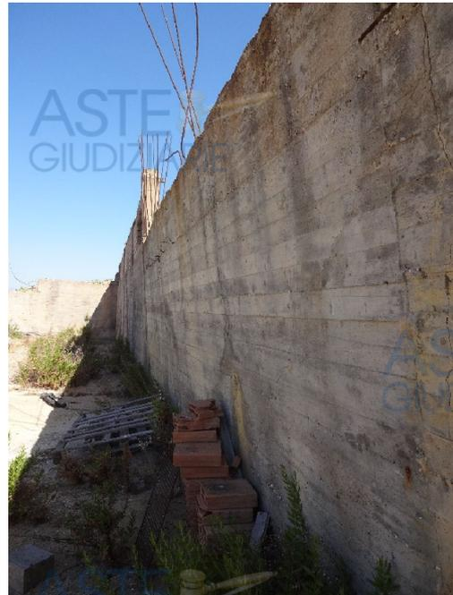
Foto 23-Muro di contenimento in cemento armato posto in prossimità del fabbricato (notevolmente deformato dalla spinta del retrostante terrapieno)
