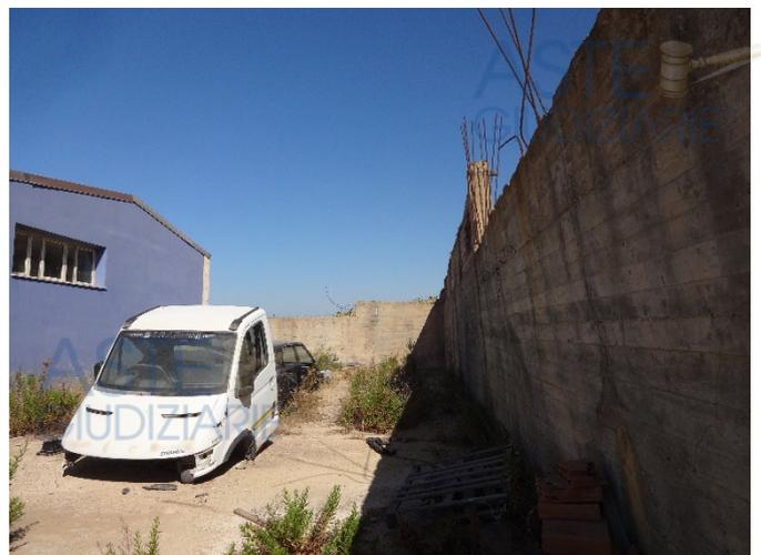
Foto 26-Muro in cemento armato a breve distanza dal fabbricato (notevolmente deformato dalla spinta del retrostante terrapieno)
