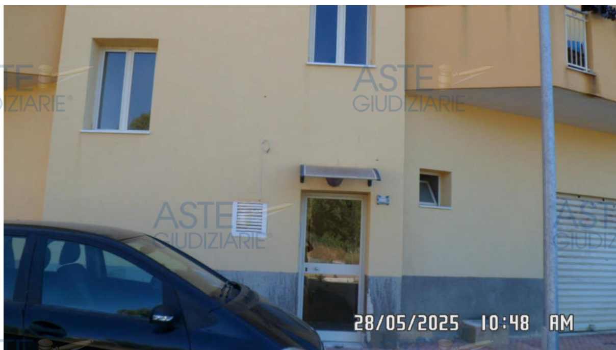
Foto 2 – Veduta del portone d'ingresso e dell'ingresso dell'autorimessa su via Leonardo Sciascia
