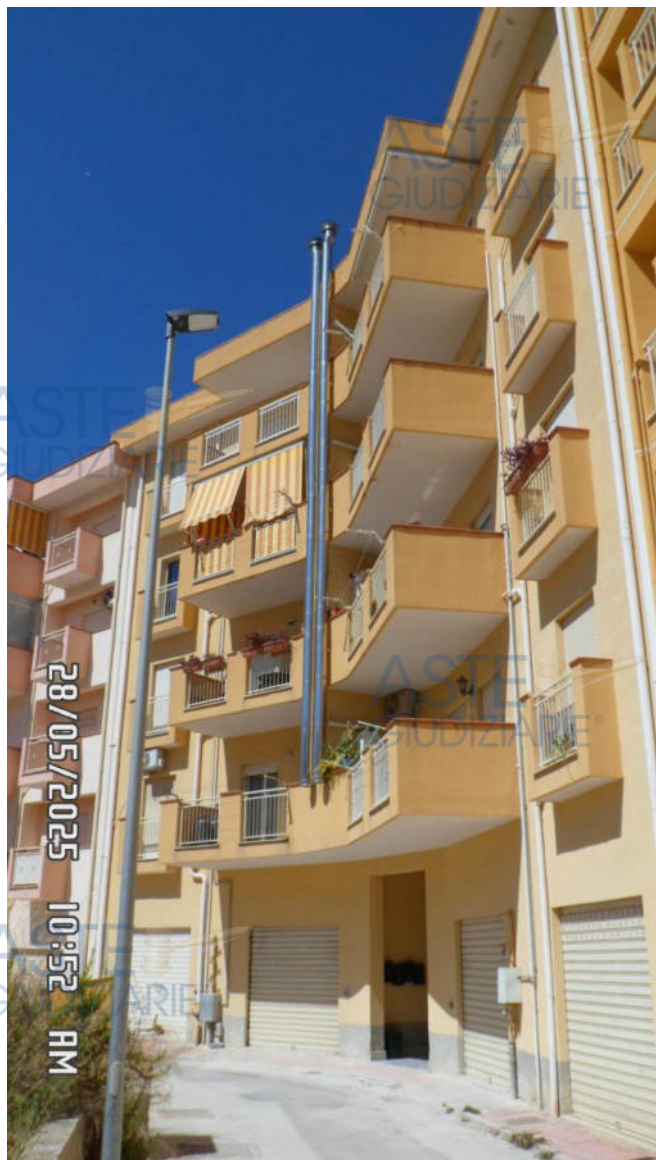
Foto 5 – Veduta dell'appartamento da via Antonino Cassarà
