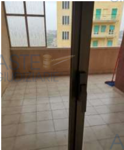
Foto n° 17 Balcone su via Imera
