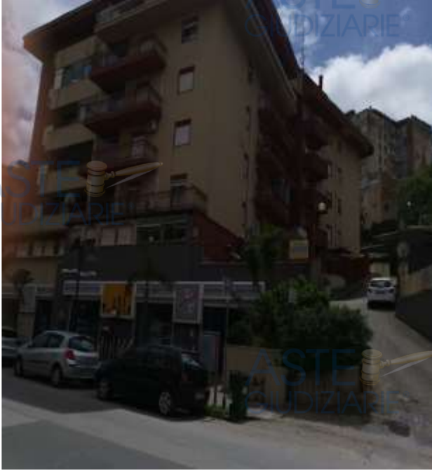
Foto n.1 Prospetto dalla via Imera
