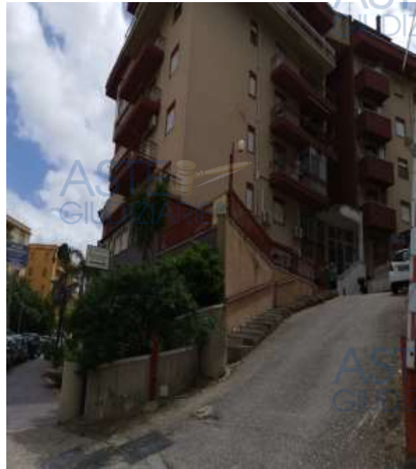
Foto n.2 Prospetto dalla traversa di via Imera
