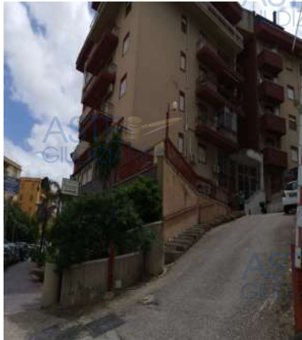
Foto n.2 Prospetto dalla traversa di via Imera
