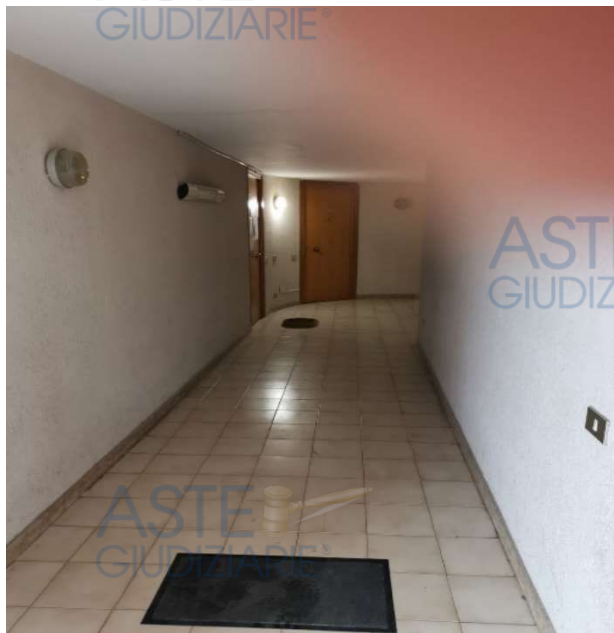
Foto n° 4 Corridoio interno al piano terra
