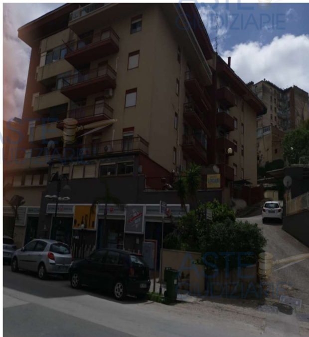
Foto n.1 Prospetto dalla via Imera
