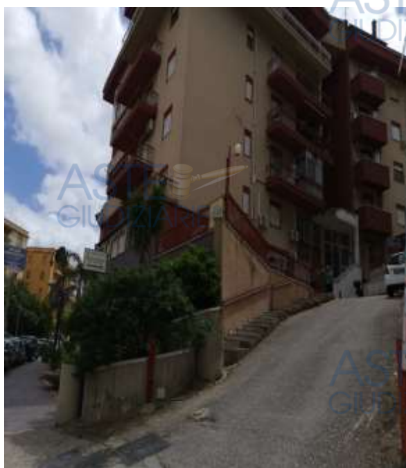
Foto n.2 Prospetto dalla traversa di via Imera
