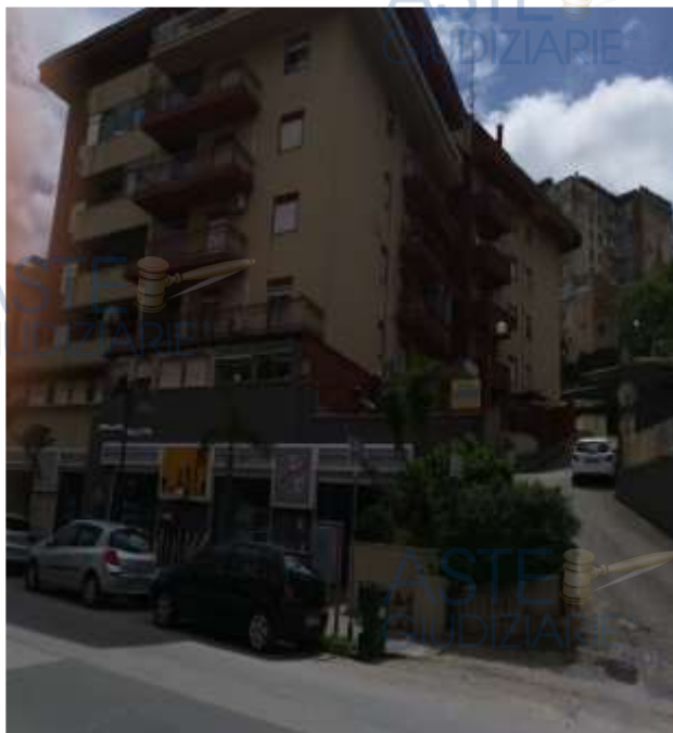
Foto n.1 Prospetto dalla via Imera
