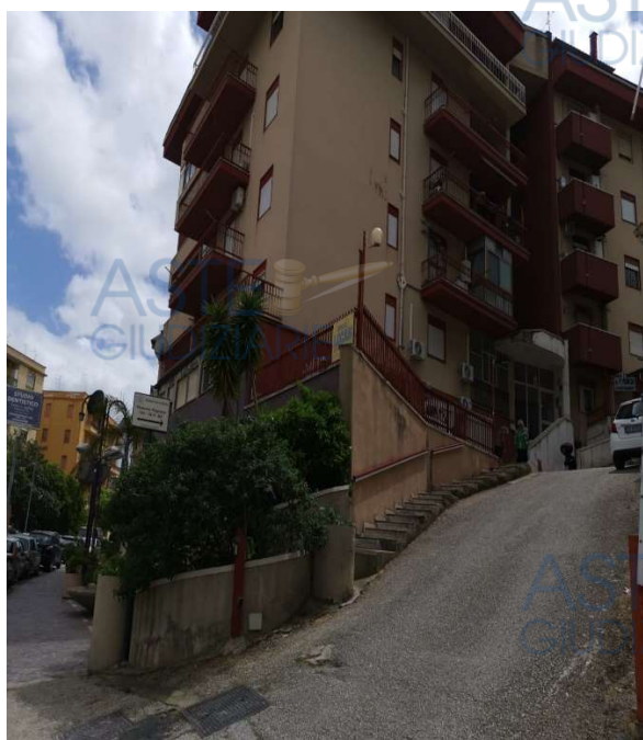
Foto n.2 Prospetto dalla traversa di via Imera
