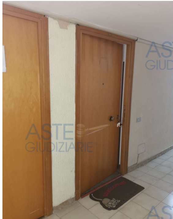
Foto n° 6 Porta di ingresso all'unità
