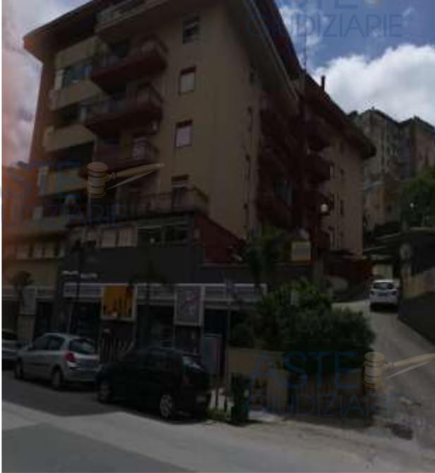
Foto n.1 Prospetto dalla via Imera
