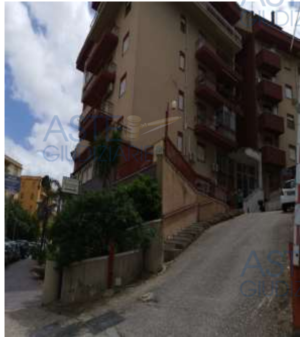
Foto n.2 Prospetto dalla traversa di via Imera
