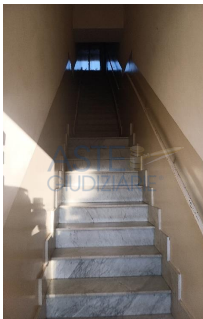
Particolare Scala Condominiale
