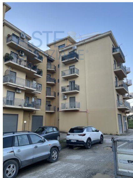
Foto n. 5 – Vista prospetto secondario
