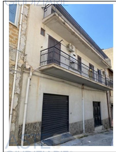
Foto 2 - Prospetto su via Vaccaro
