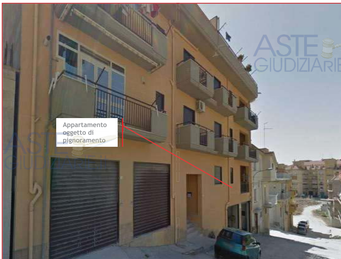
Foto 1 – Vista Complesso Edilizio – Lato Nord
