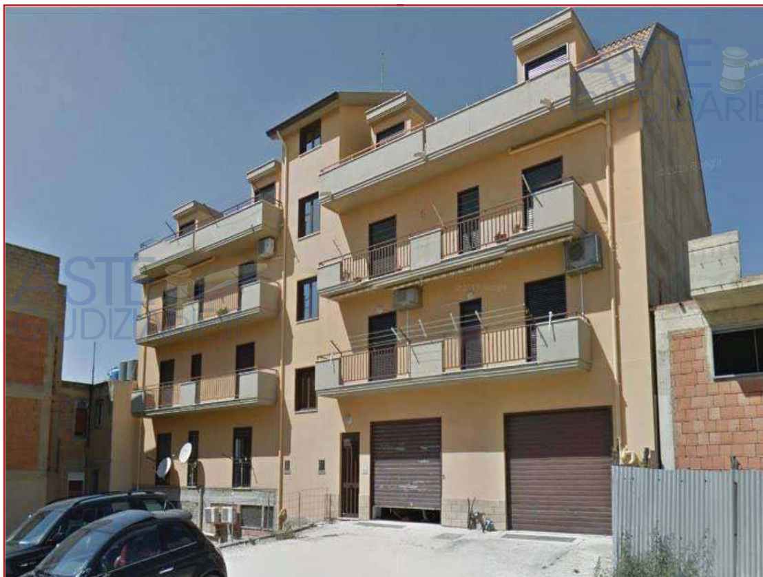
Foto 2 – Vista Complesso Edilizio – Lato SUD
