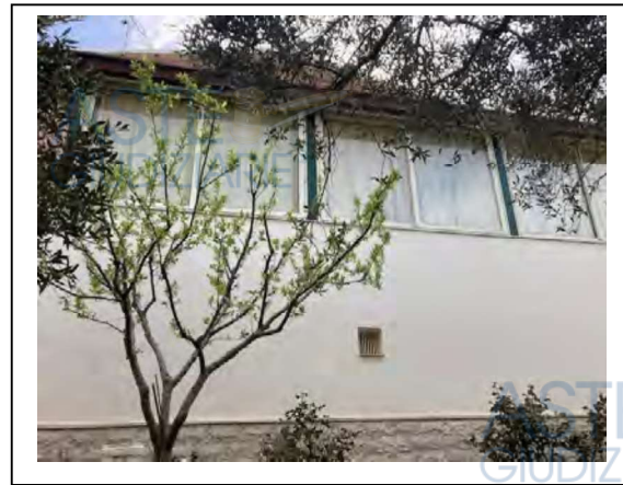
Esterno retro fabbricato Prospetto Nord/Ovest
