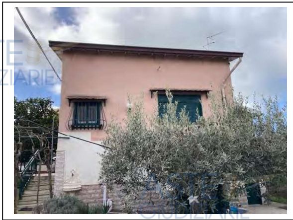
Esterno fabbricato Prospetto Nord/Est
