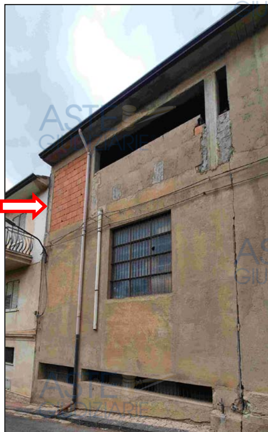
Immobile + Veranda 1°P via Luigi Sturzo
