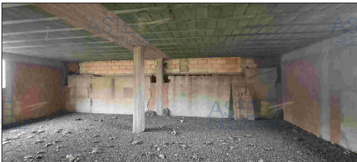
Veranda Immobile in corso di costruzione 1°P via Luigi Sturzo
