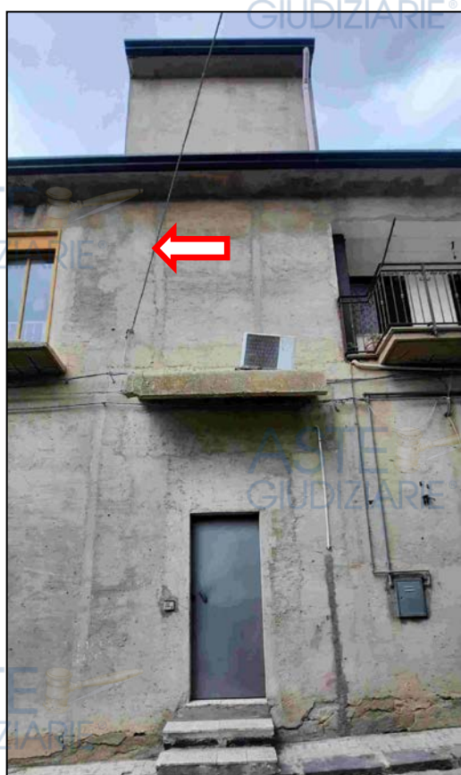
Ingresso Edificio su via Luigi Sturzo
