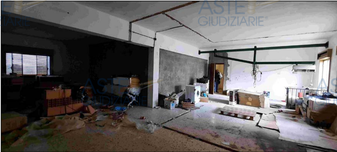
Interno Immobile in corso di costruzione 1°P via Luigi Sturzo
