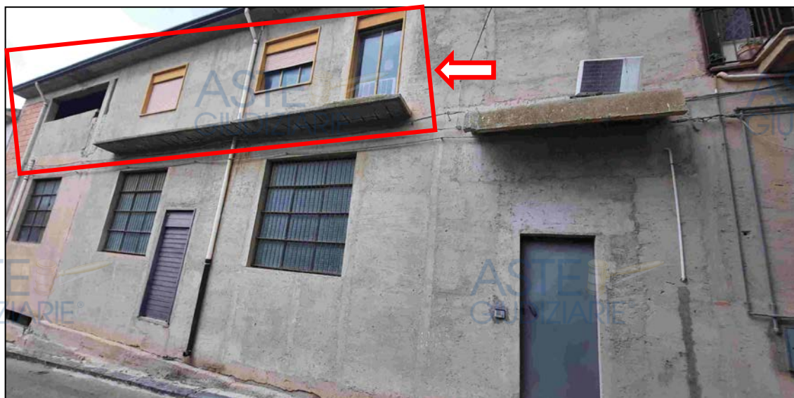
Ingresso Edificio su via Luigi Sturzo
