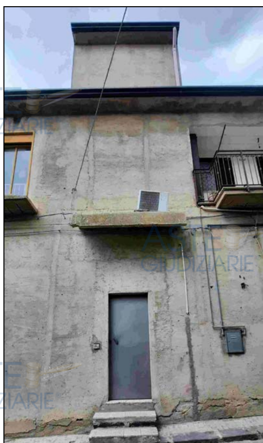
Ingresso Edificio su via Luigi Sturzo
