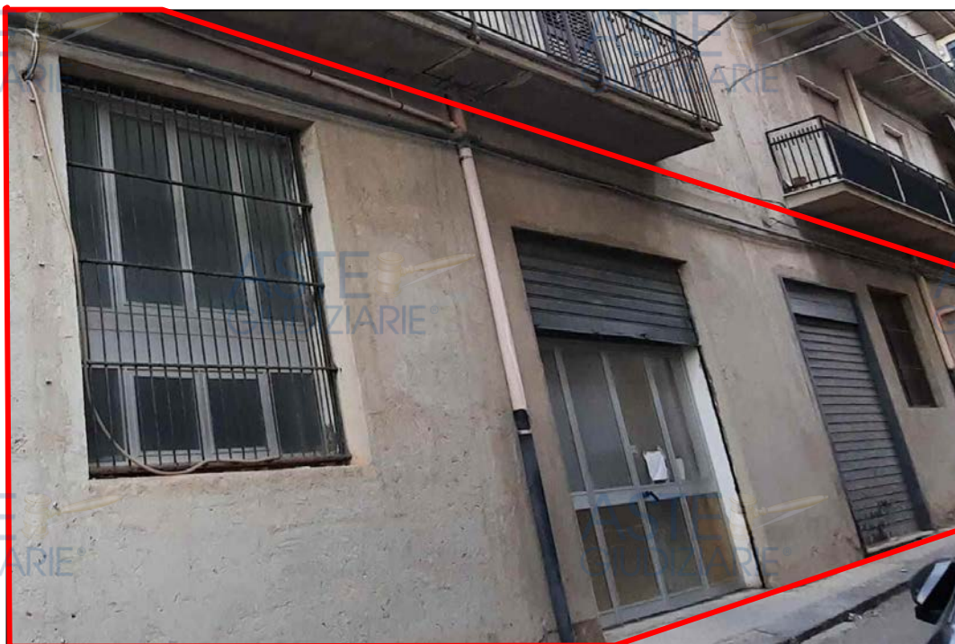
Ingresso Deposito Attività Commerciale su via Luigi Sturzo
