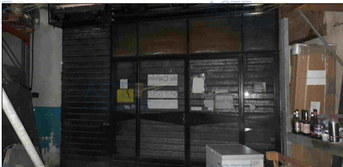
Ingresso Deposito da via Edison n. 175
